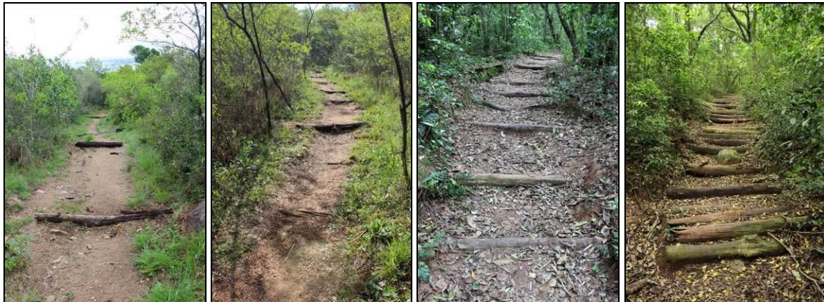
Figura 26 - Toras de madeira dispostas perpendicularmente às trilhas do Parque Natural Morro do Osso para contenção da força das águas e da erosão.
