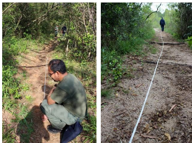
Figura 21 - Medições da erosão visível.
