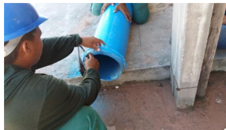
Figura 10 – Encanador serrando a borda da tubulação cortada obliquamente e chamada de bisel
