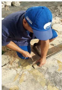
Figura 9 – encanador realizando a montagem de tubulação com materiais diferentes (mealhar)
