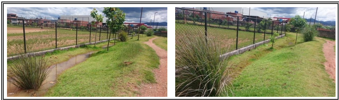
Figura 32 e 33. Fotos das valas gramadas. Úmida e seca. Fonte: AUTORA (2016).
