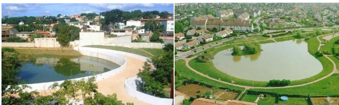
Figura 2 e 3 – Fotos, respectivamente, de bacia de detenção – Belo Horizonte, MG e estrutura de retenção de água de chuva. Fonte: Baptista, 2014.
