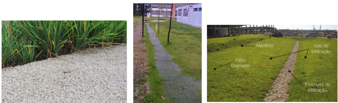
Figura 4, 5 e 6 – Fotos, respectivamente, de pavimento permeável no Viaduto Cidade de Guarulhos, canal gramado e sistema Filtro-Vala- Trincheira de infiltração no campus da UFSCAR. Fonte: Autora, 2018;Pereira, 2016; Lucas et al, 2015 adaptado de Gutierrez et al, 2010.
