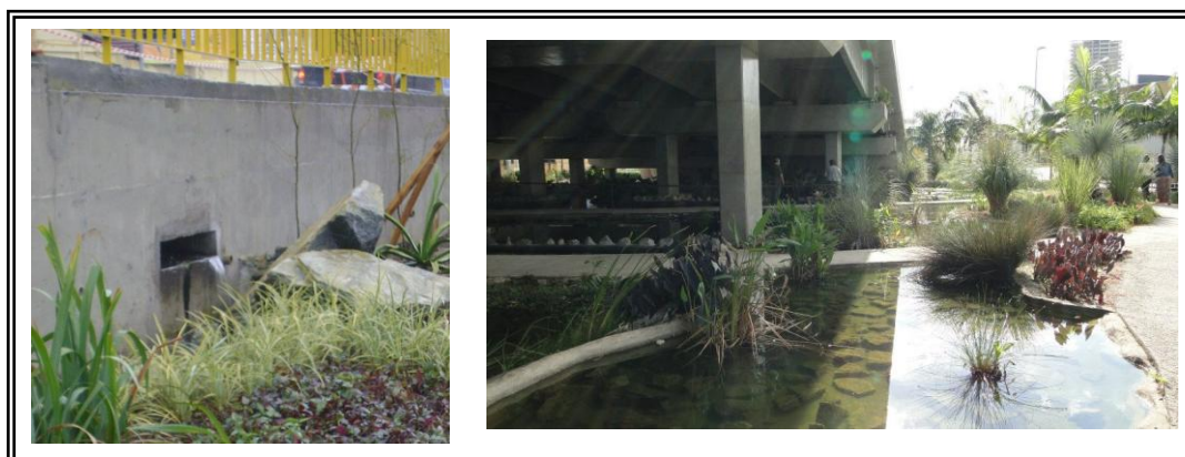
Figura 49 e 50. Fotos, respectivamente, da entrada de água de chuva escoada da rua, e dos espelhos d'água sob Viaduto. Fonte: AUTORA (2013).
