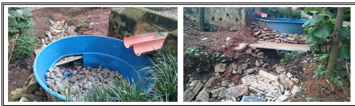
Figura 38 e 39. Fotos dos dispositivos (poços abertos) para desaceleração da velocidade da água e infiltração – TC ParCão. Fonte: AUTORA, 2016.
