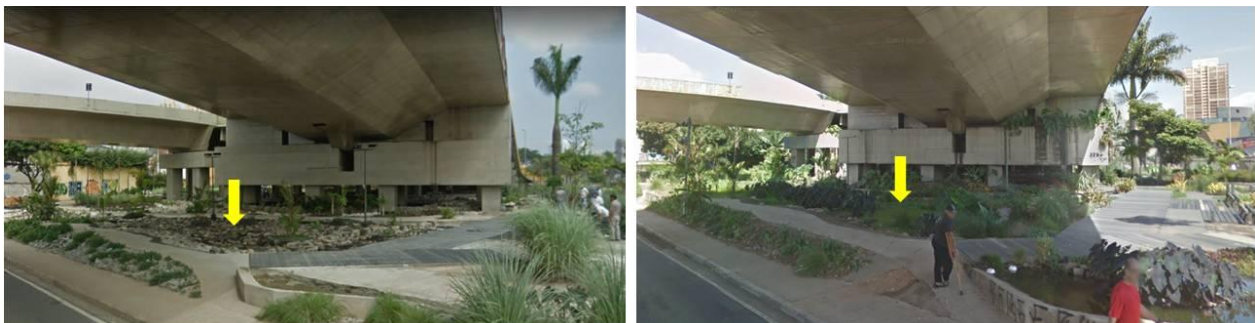
Figura 69. Foto da visão geral da TC Viaduto – bacia de infiltração – no período de construção (2011, à esquerda) e atualmente (2017, à direita) – Guarulhos, SP. Fonte: Imagem Google Maps (busca em fevereiro/2018).
