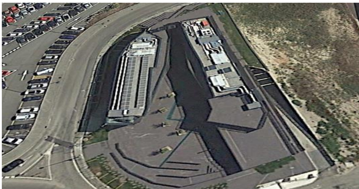
Figura 5.12 – Painéis solares no edifício de serviços
