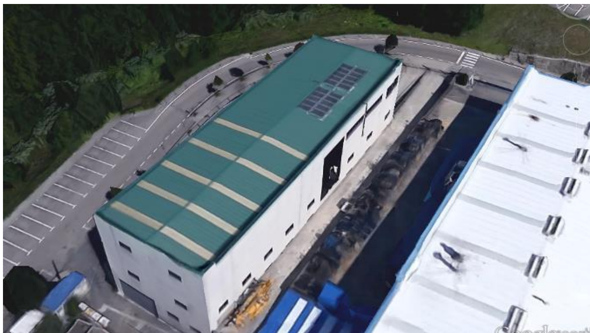
Figura 5.13 – Painéis solares nos demais edifícios
