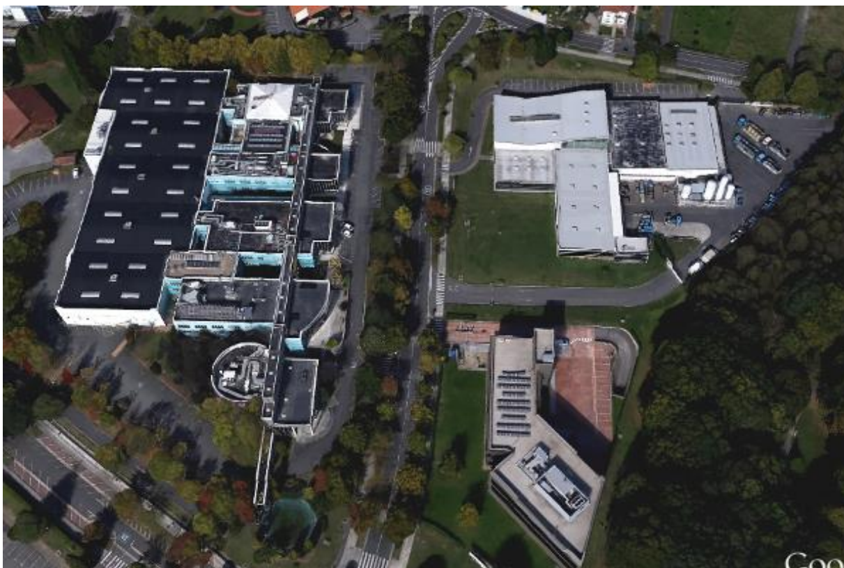
Figura 5.15 – Painéis solares nos demais edifícios
