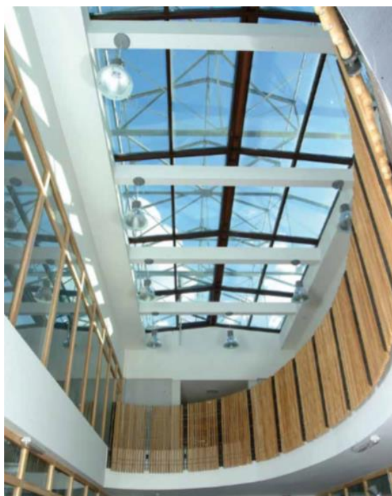
Figura 6.4 – Claraboia transparente do edifício administrativo do PCTMAT
