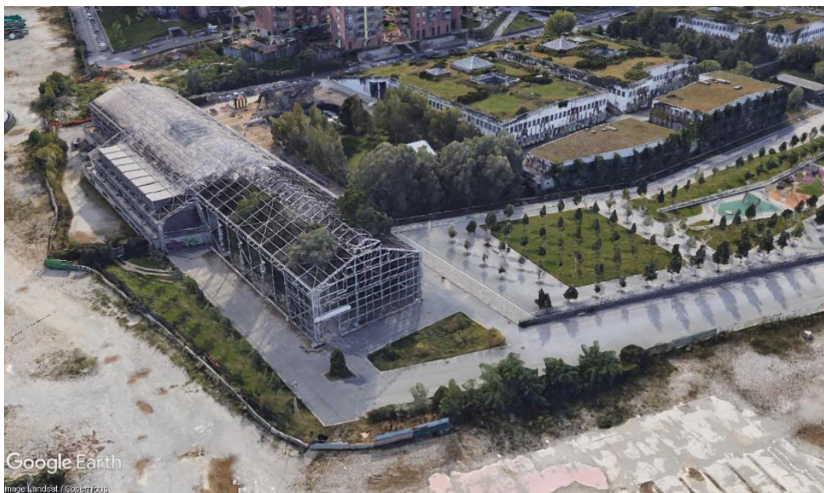
Figura 6.6 – Estrutura da antiga fábrica incorporada no PCTMAT
