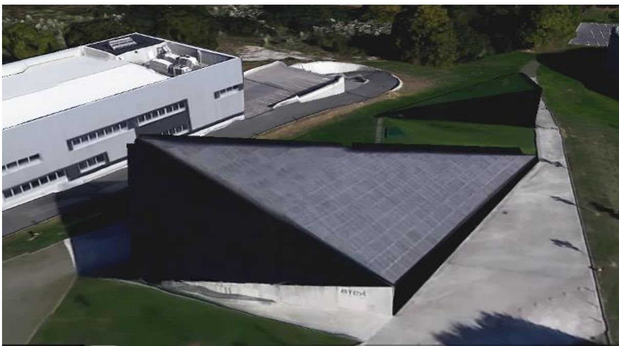
Figura 5.14 – Painéis solares no BTEK
