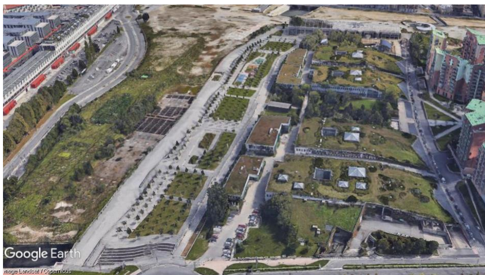
Figura 6.3 – Telhado verde nas coberturas do PCTMAT
