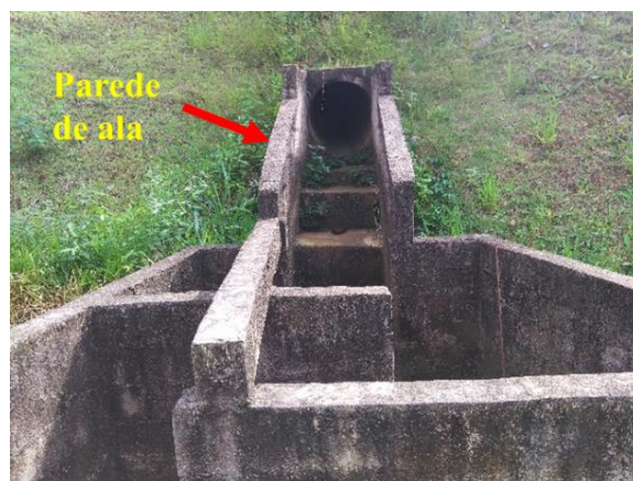
Figura 113 – Estrutura de entrada tipo IV
