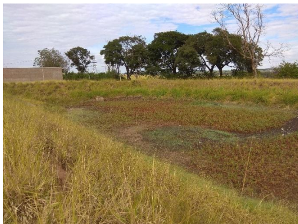
Figura 97 – Vista geral da BD Parque Novo Mundo (costado sul)
