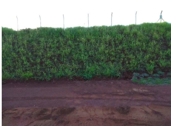
Figura 121 – Talude com cobertura, fundo sem cobertura
