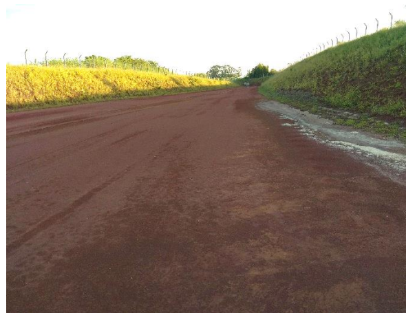
Figura 54 – Vista geral interior BD saída norte UFSCar
