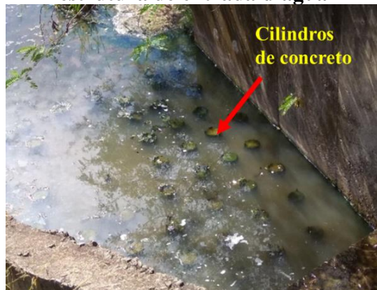
Figura 115 – Cilindros de concreto em estrutura de entrada d'água
