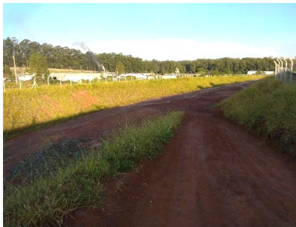
Figura 53 – Vista geral acesso BD saída norte UFSCar
