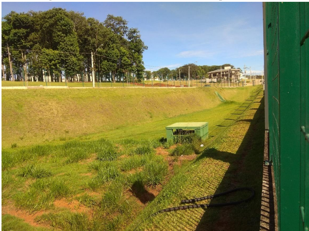
Figura 87 – Vista Geral interior da BD Parque Faber III
