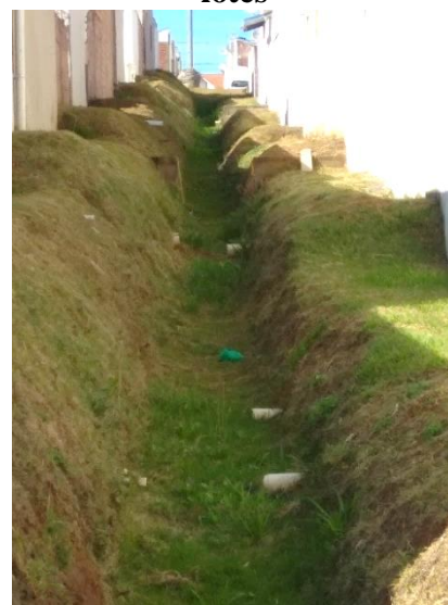
Figura 77 – Drenagem dos lotes
