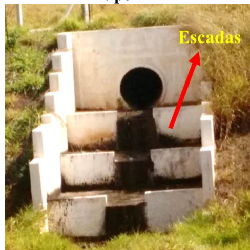
Figura 111 – Estrutura de entrada tipo II
