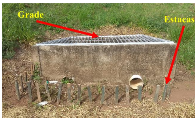
Figura 116 – Estrutura de saída d'água tipo I
