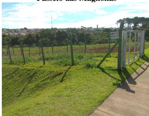
Figura 82 – Vista geral exterior da BD Passeio das Magnólias
