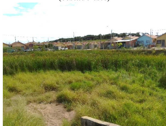
Figura 95 – Vista geral BD Planalto Verde (costado este)
