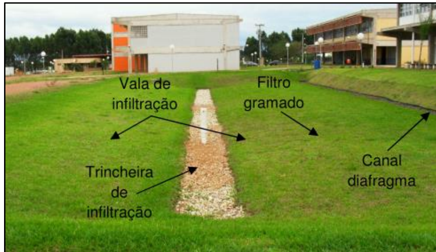
Figura 6 - Trincheira de infiltração
