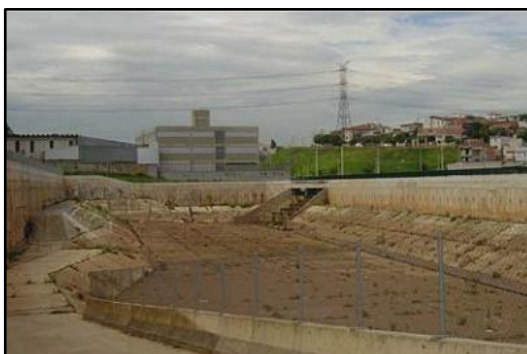
Figura 15 - Bacia de detenção com revestimento em concreto
