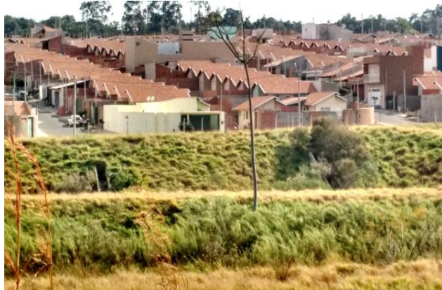
Figura 70 – Vista geral exterior da BD Jardim Araucária – Fase 01
