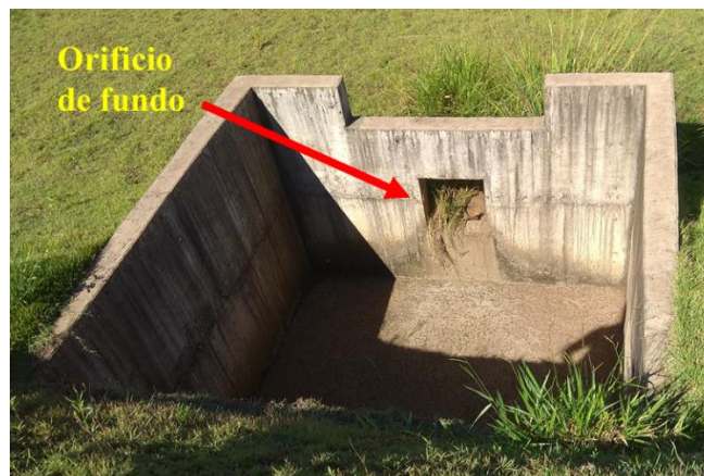
Figura 119 – Estrutura de saída d'água tipo IV
