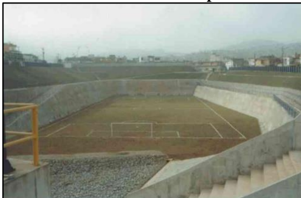
Figura 129 – Reservatório de contenção em São Bernardo do Campo/SP
