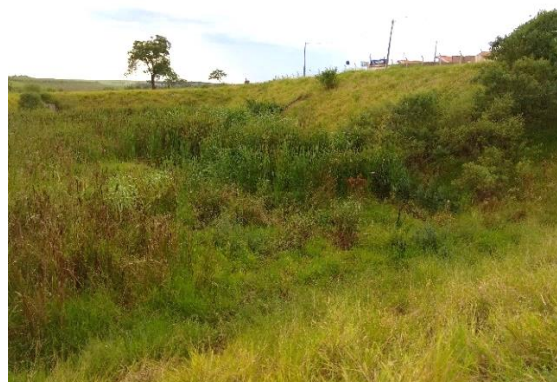
Figura 71 – Vista geral interior da BD Jardim Araucária – Fase 01
