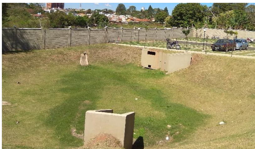
Figura 61 – Vista geral interior da BD Parque Monte Logan
