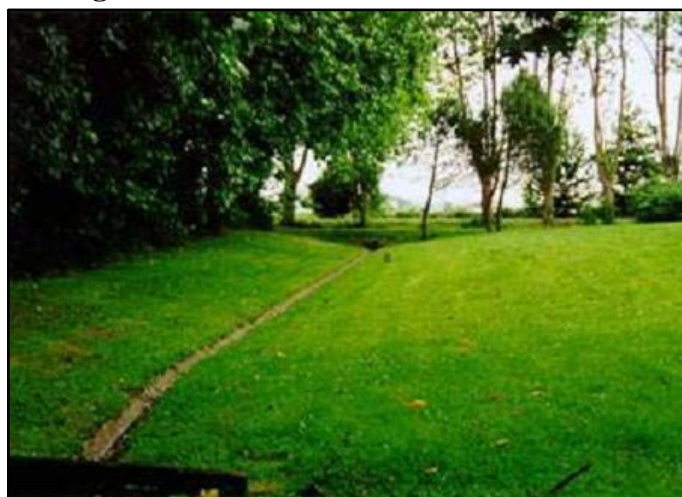
Figura 7 - Vala com canaleta em concreto
