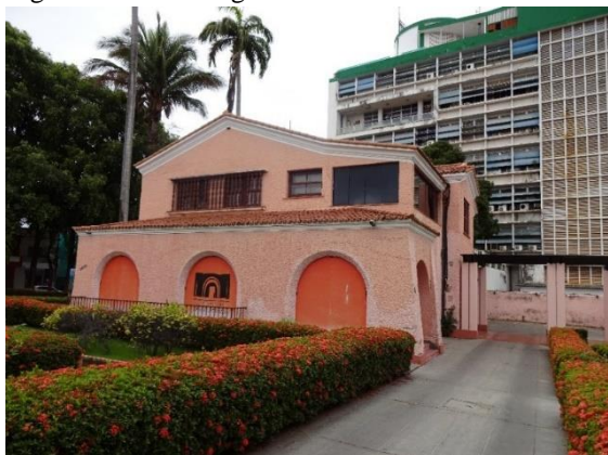
Figura 1- Casa dos governadores em Cuiabá
