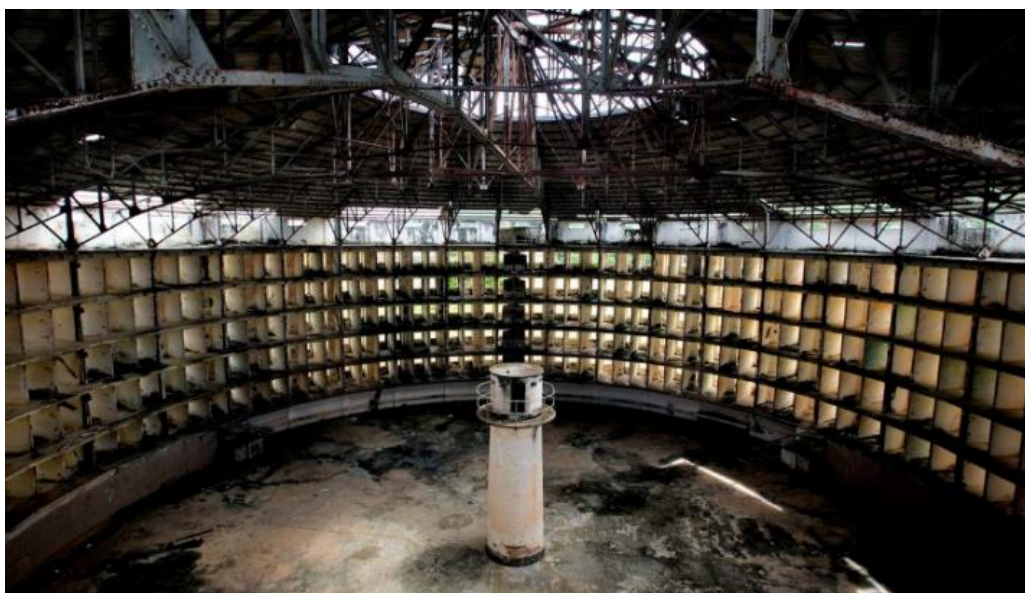
Figura 2.1. Modelo de centro penitenciário segundo arquitetura do filósofo Jeremy Bentham, empregando o conceito de panóptico
