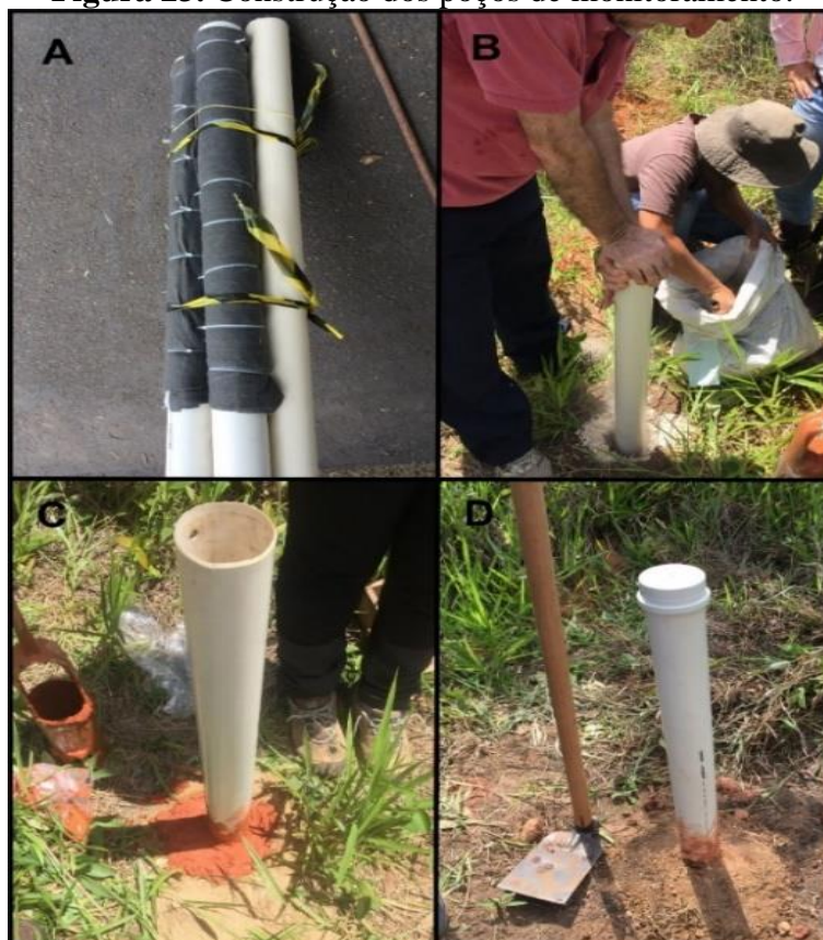
Figura 23. Construção dos poços de monitoramento.
