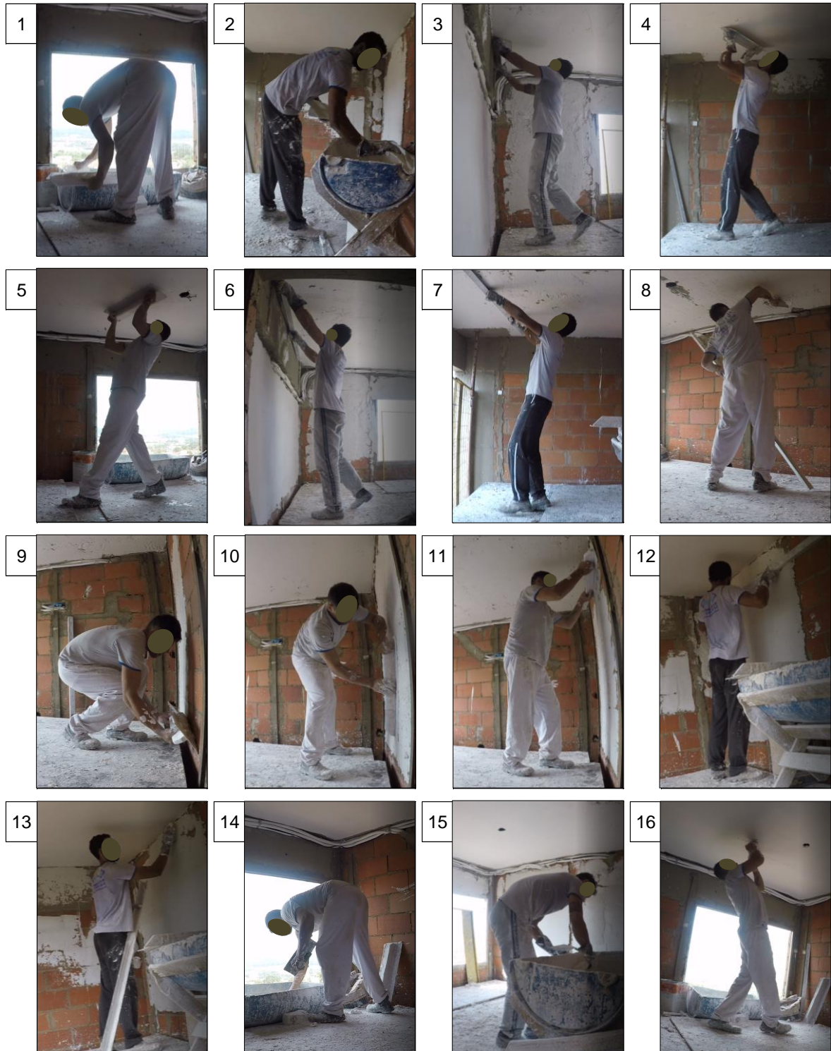
Figura 32 – Posturas adotadas na tarefa de revestimento do teto
