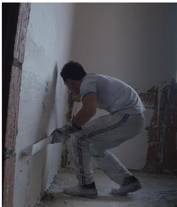
Figura 5 - Execução do revestimento sarrafeado
