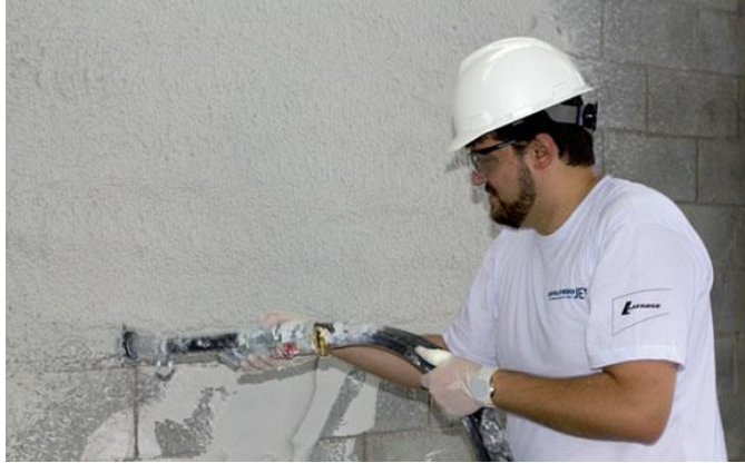
Figura 52 - Aplicação de gesso projetado
