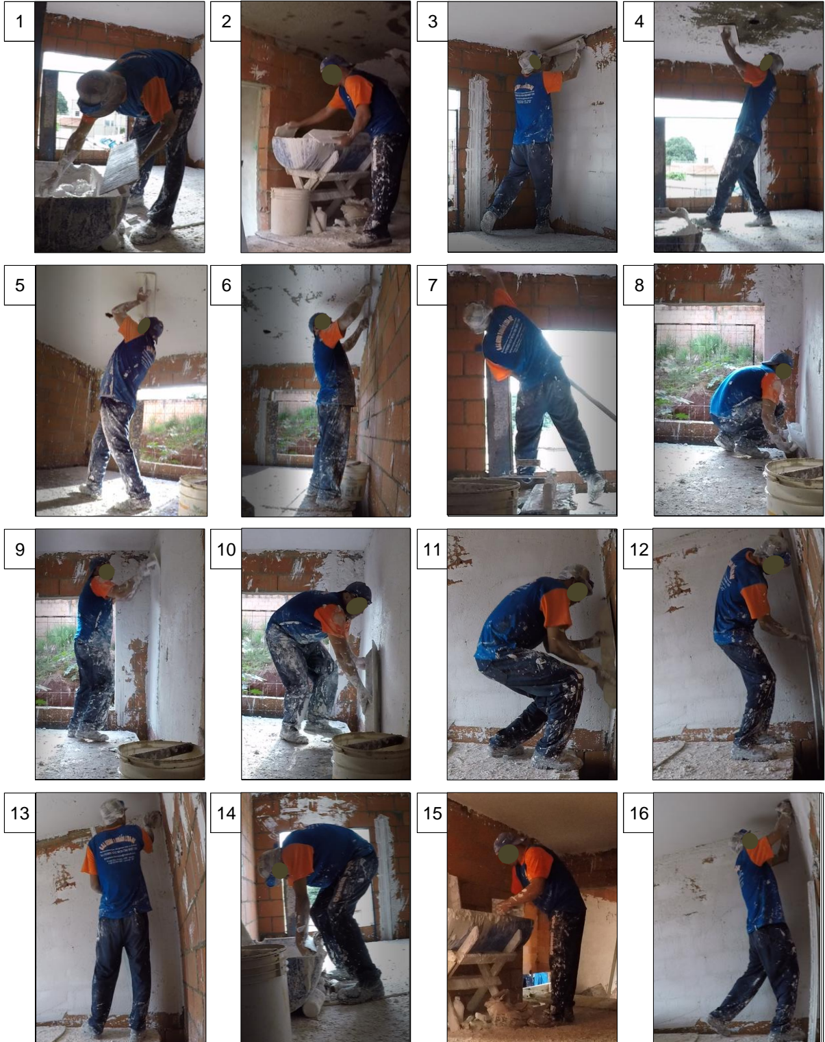
Figura 24 – Posturas adotadas na tarefa de revestimento do teto
