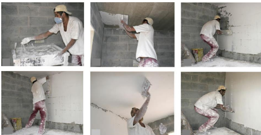
Figura 4 - Processo de execução do revestimento desempenado
