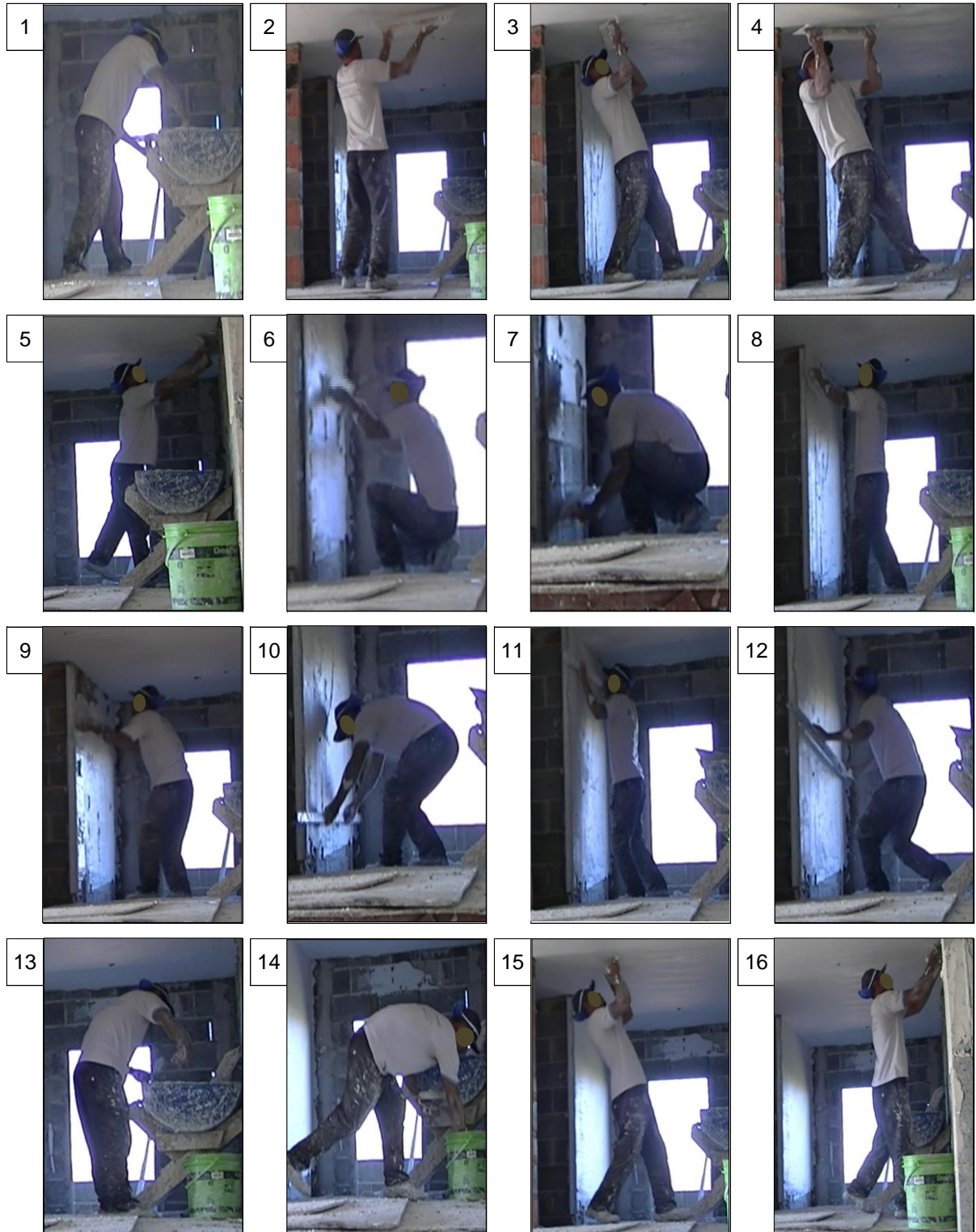
Figura 18 – Posturas adotadas na tarefa de revestimento do teto e parede superior
