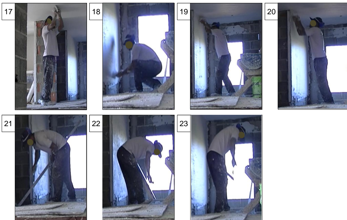
Figura 19 – Posturas adotadas na tarefa de revestimento do teto e parede superior (Continuação)
