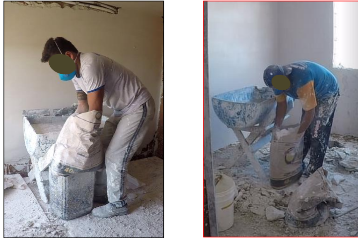
Figura 48 – Polvilhar o gesso sobre a água com e sem um apoio
