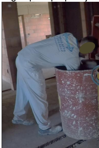
Figura 47 – Pegar água para preparação da pasta de gesso
