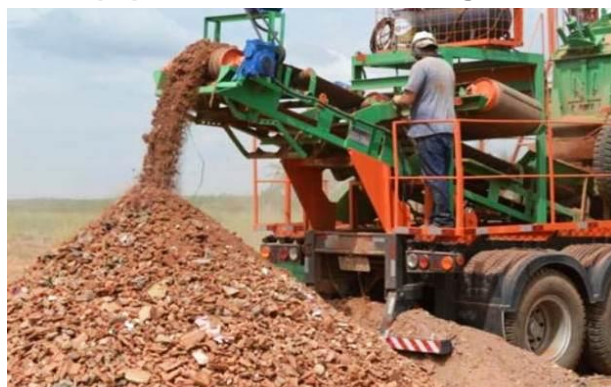
Figura 20. Equipamento móvel de britagem do CONSAB.
