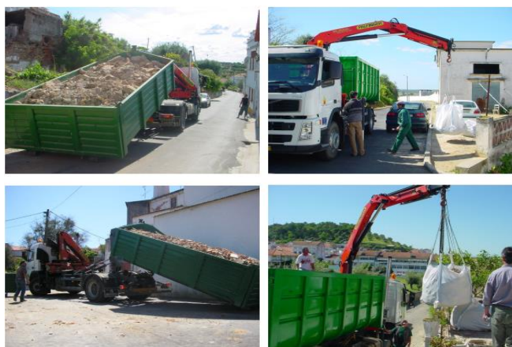
Figura 30. Recolha de RCC em obras através do sistema municipal.
