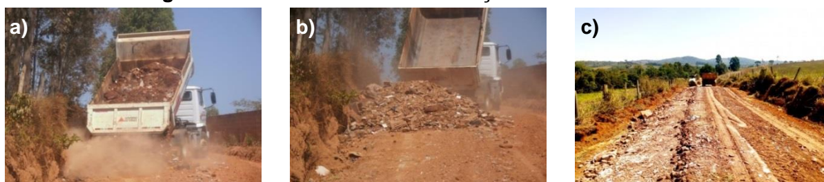
Figura 42. Uso de RCC na manutenção de estradas rurais.
