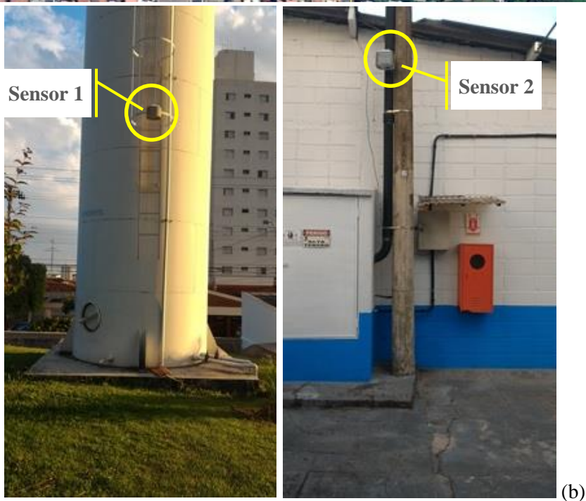
Figura 21 – a) pontos de coleta de dados na FESC, b) Sensores instalados
