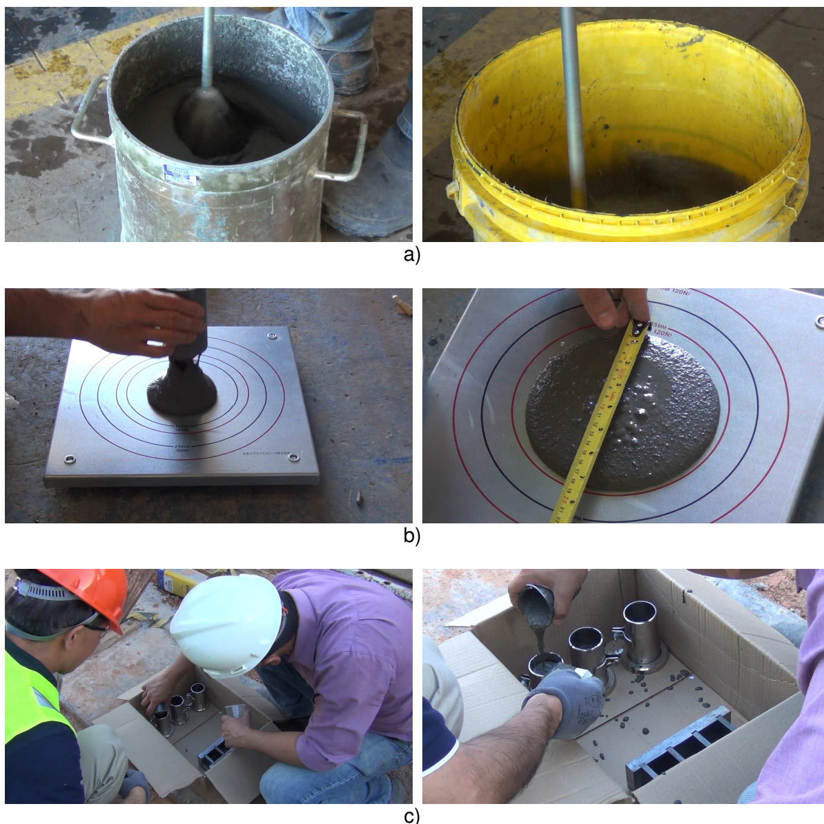
Figura 3.23: Confeção do graute de preenchimento das luvas metálicas, ensaio de espalhamento e moldagem dos corpos-de-prova.
