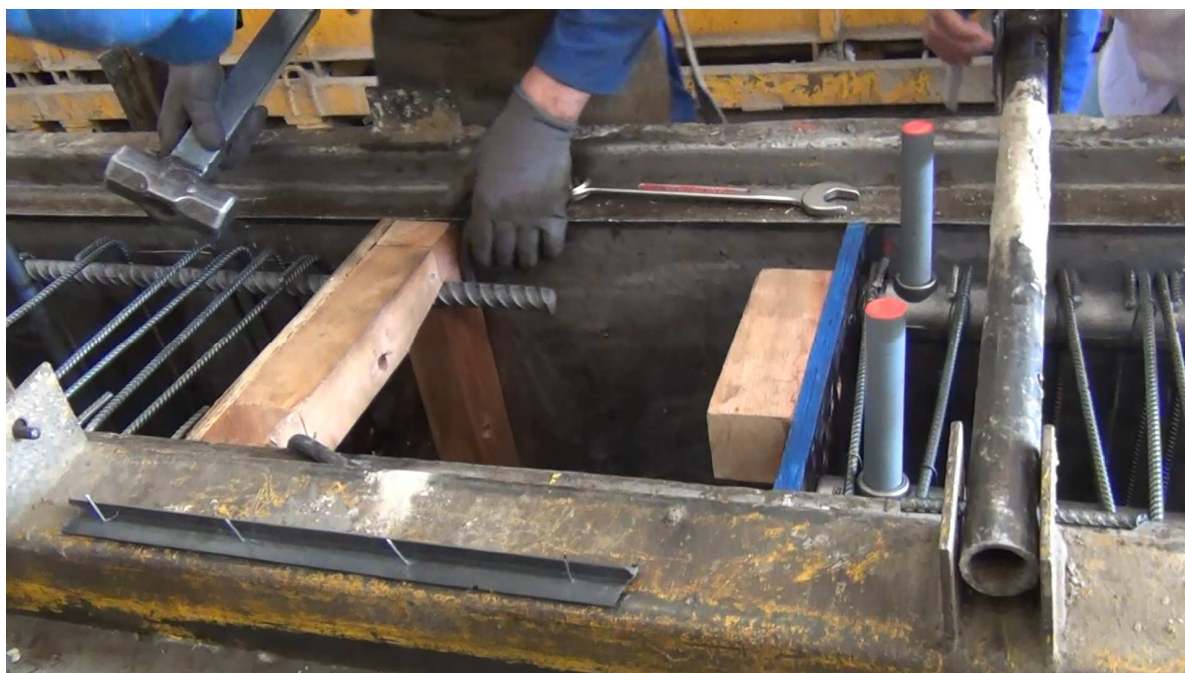
a) armações conjugadas posicionadas na forma
