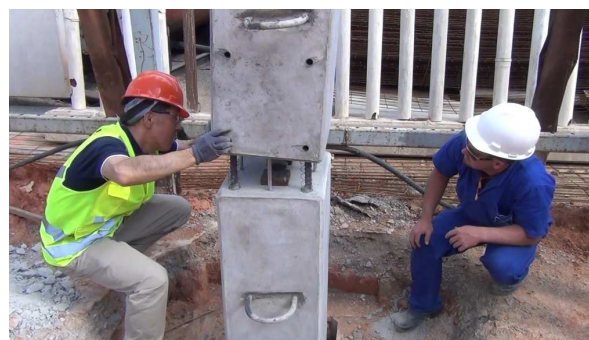
Figura 3.19: Verificação do comprimento e posicionamento das esperas e chumbadores.
