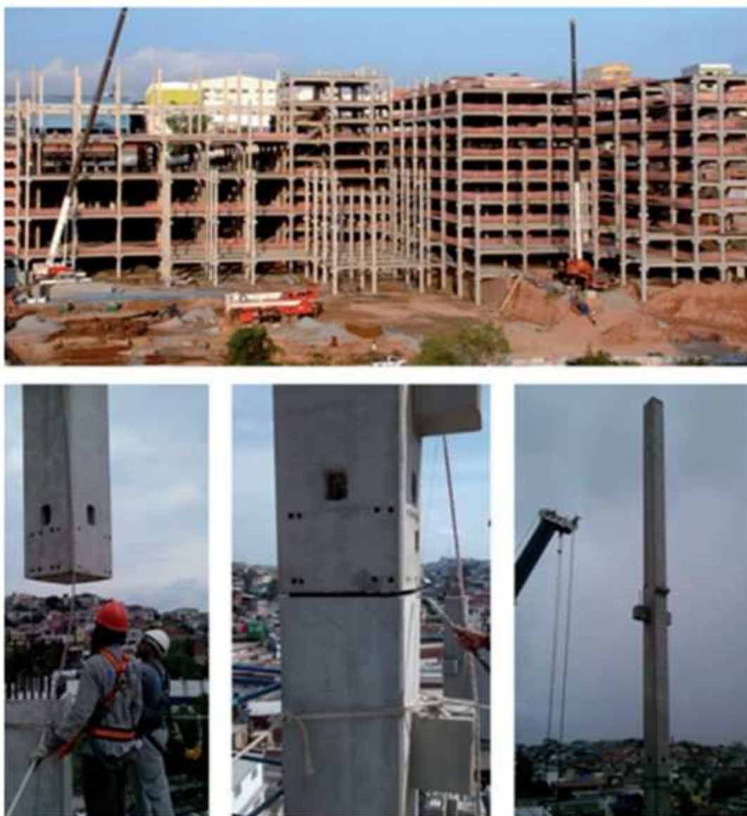
Figura 2.11: Aplicação de ligação pilar-pilar no Plaza Shopping Carapicuíba.
