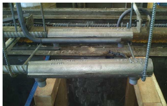
Figura 3.10: Encaixe dos tubos PVC prolongadores da entrada e saída de graute na luva metálica.
