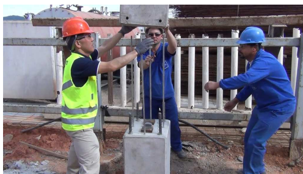
Figura 3.19: Verificação do comprimento e posicionamento das esperas e chumbadores.
