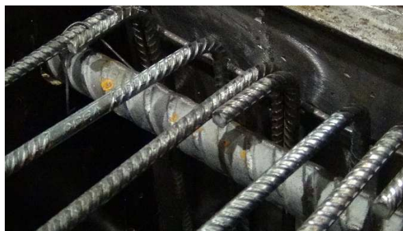
c) espaço vazio entre a armadura principal e o estribo
