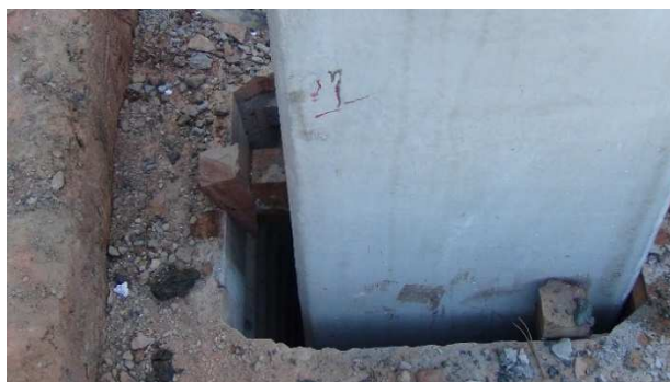
c) pé da peça inferior, com cunhas para o prumo
