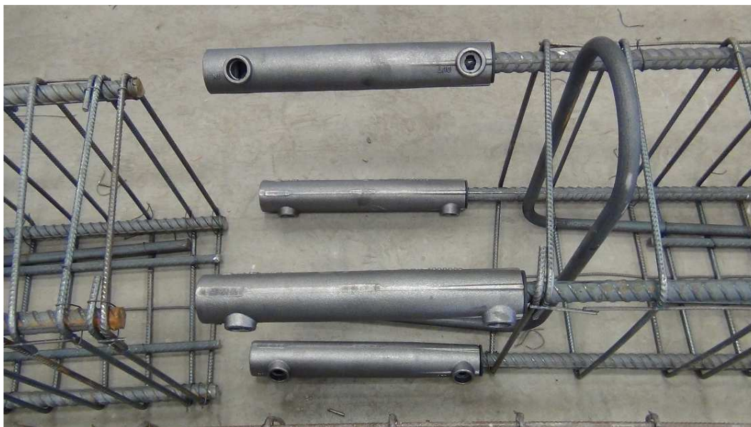
Figura 3.9: Encaixe da luva metálica na barra de aço.
