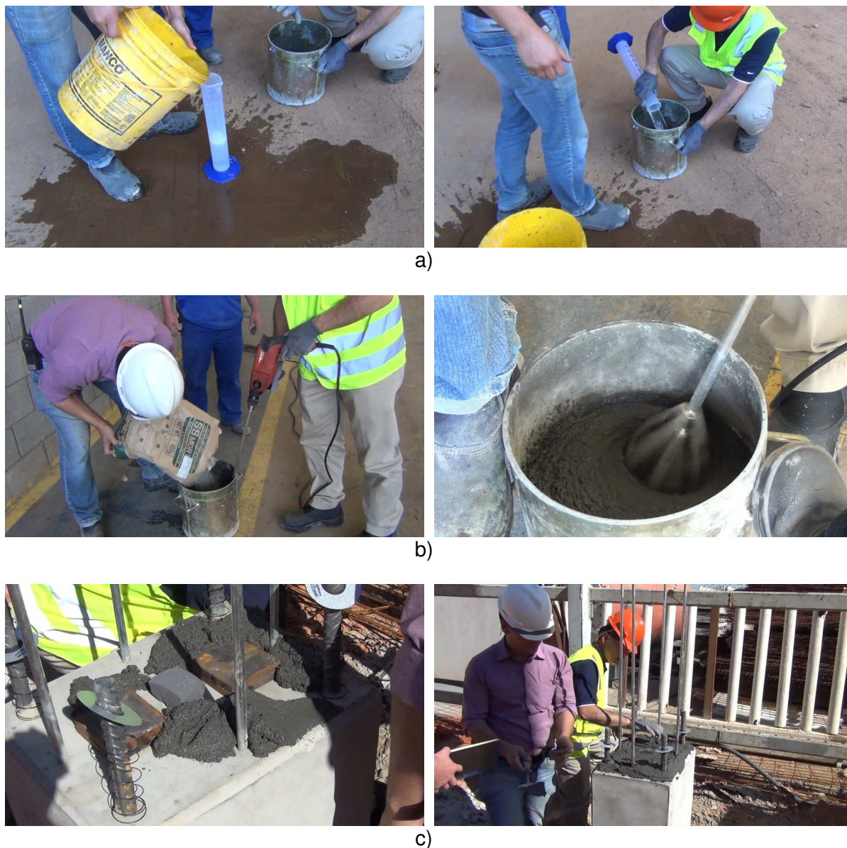
Figura 3.20: Confeção e colocação da argamassa de assentamento.
