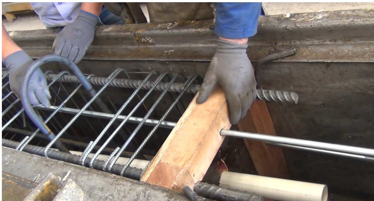
a) colocação dos chumbadores
