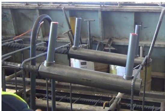
Figura 3.10: Encaixe dos tubos PVC prolongadores da entrada e saída de graute na luva metálica.
