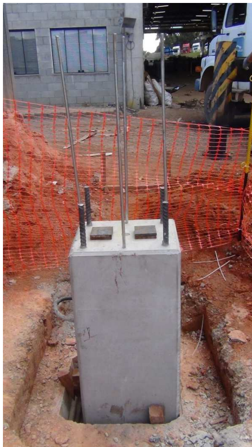
a) peça inferior nivelada
