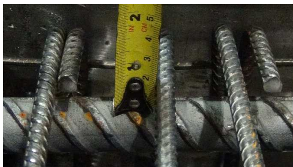
c) espaço vazio entre a armadura principal e o estribo
