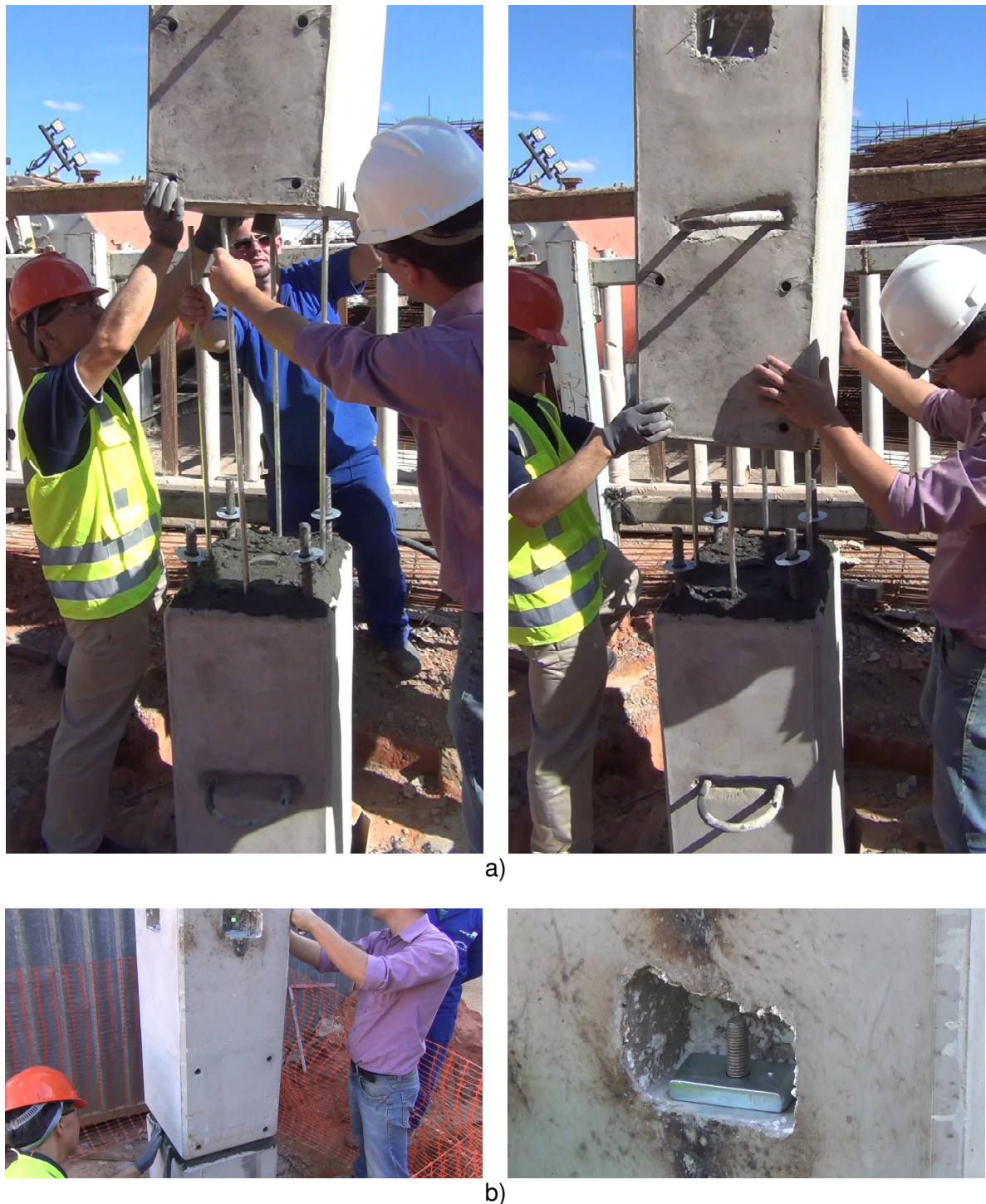
Figura 3.21: Montagem da peça superior do modelo L.
