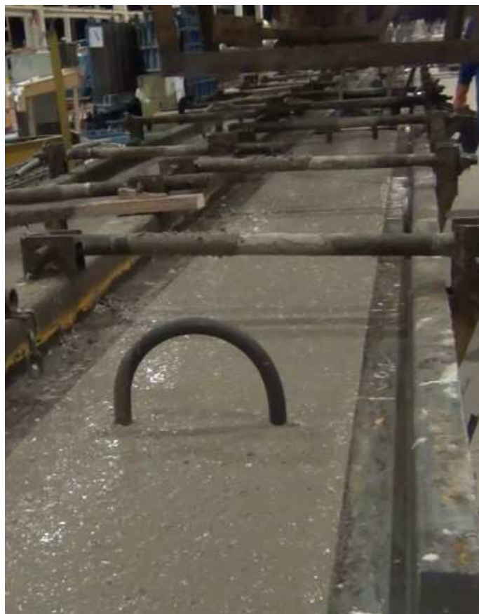
b) lançamento do concreto realizado
