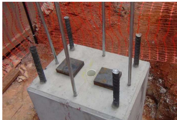
b) topo da peça inferior, com chapas de aço para garantir espessura da junta
