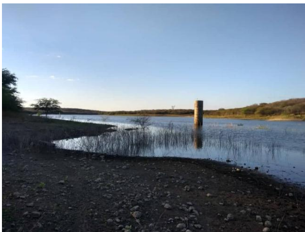
Imagem 1 – Reservatório de água localizado no Assentamento Baixa Grande em Jati/CE.
