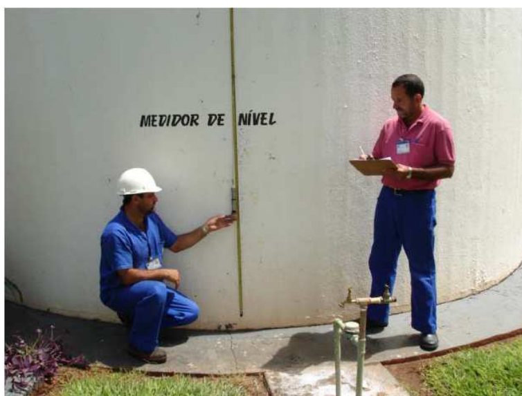
FIGURA 6.47 – Dispositivo para medição de nível de reservatório elevado
