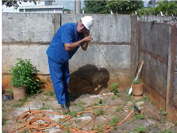
FIGURA 6.44 – Detecção de vazamentos com a haste de escuta
