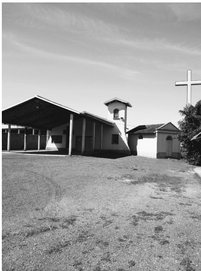
Figura 0.3. Vista frontal dos dois prédios da Igreja Santo Antônio do Monte Alto
