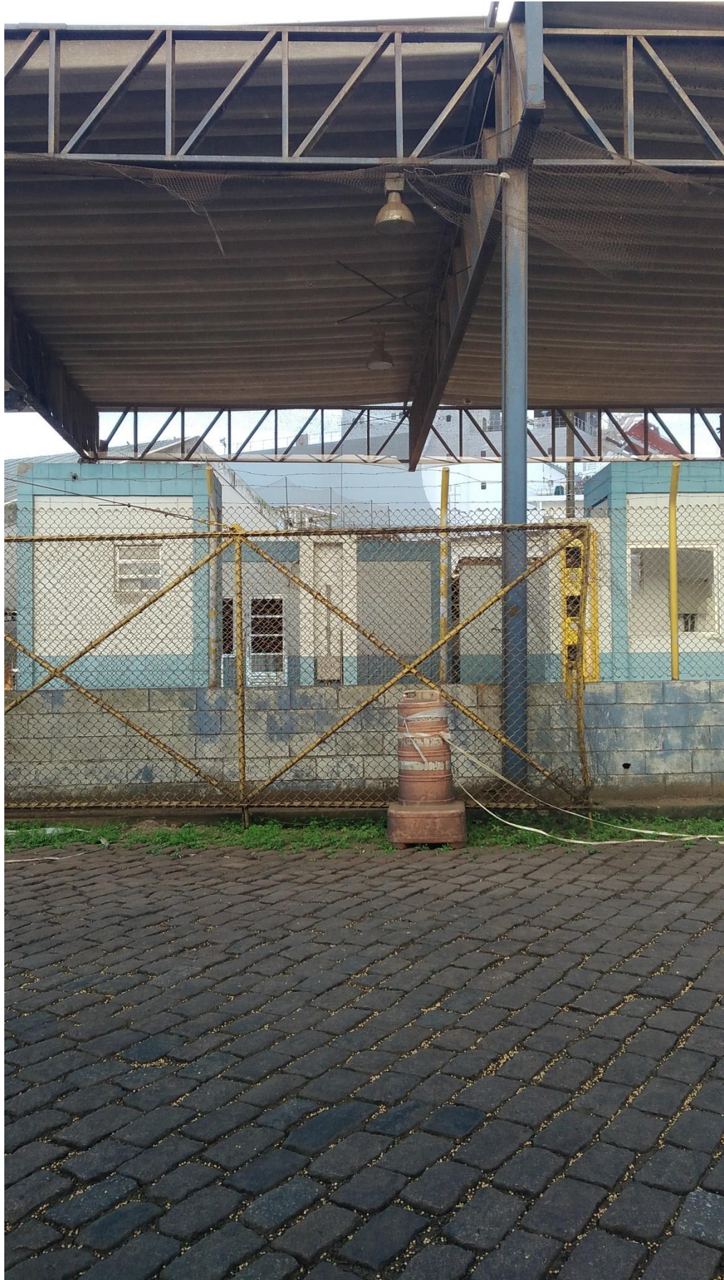
Figura 14 – Gate 12 ilustrando a presença de grãos de soja no solo e a instalação de telas em seu teto. O “xis” preto próximo às luminárias são os zíperes costurados na tela. Fonte: acervo pessoal, junho de 2017.
