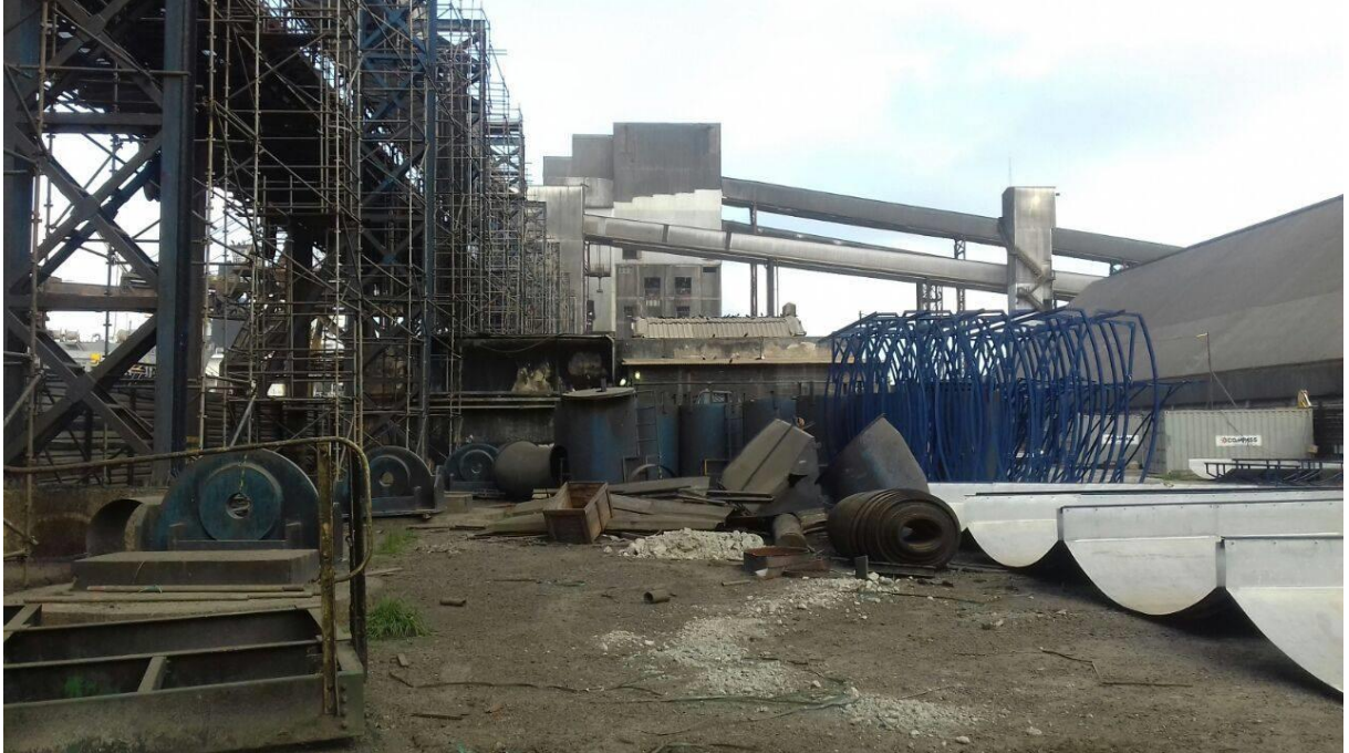
Figura 24 – Parte da área inspecionada do terminal ferroviário. Fonte: acervo pessoal, maio de 2017.
