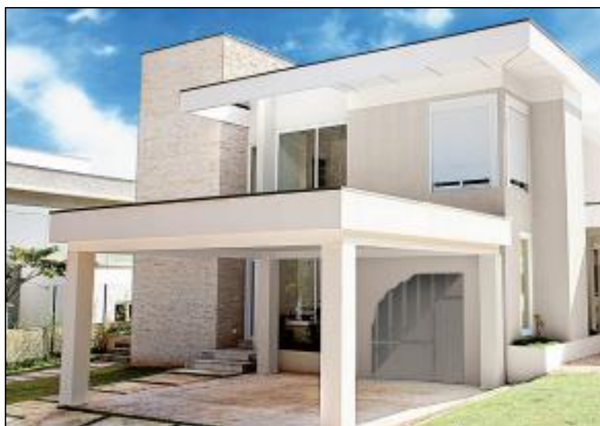
Figura 3.14 – Fachada de placas cimentícias [65].
