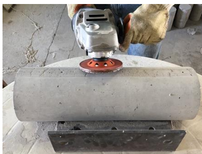
Figura 29 - Desgaste da camada superficial de concreto com disco diamantado
