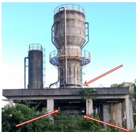
Figura 21 - Caixa d'água reforçada com CFRP aplicado segundo a técnica EBR
