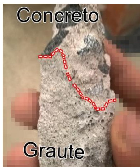
Figura 31 - Aderência entre o graute de reparo e o concreto
