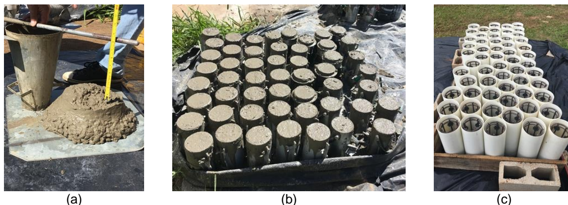
Figura 38 - Etapas de concretagem
