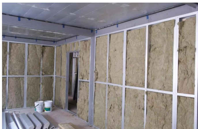
Figura 5- Aplicação de lã de rocha com revestimento termoacústico
