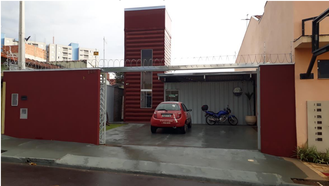
Figura 14: Imagem da fachada
