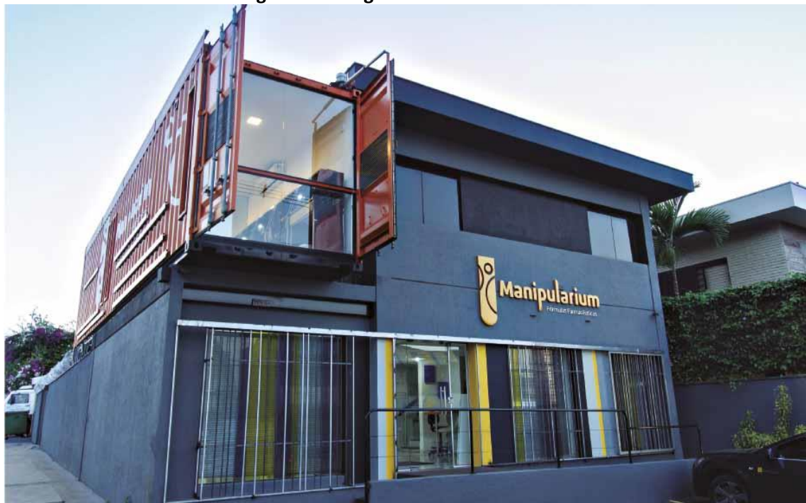
Figura 02: Imagem da fachada
