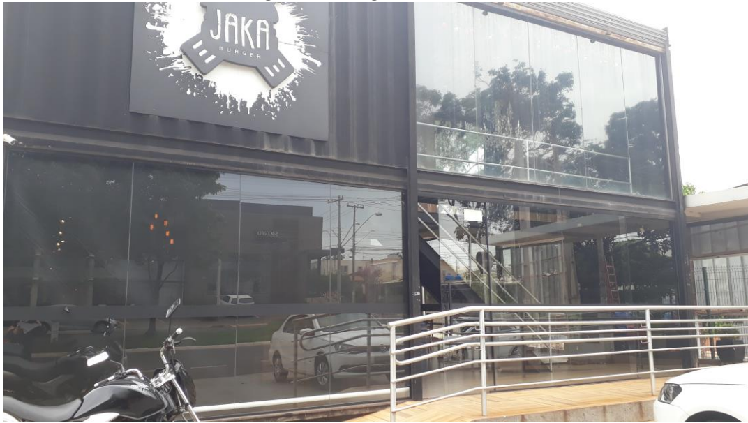
Figura 14: Imagem da fachada
