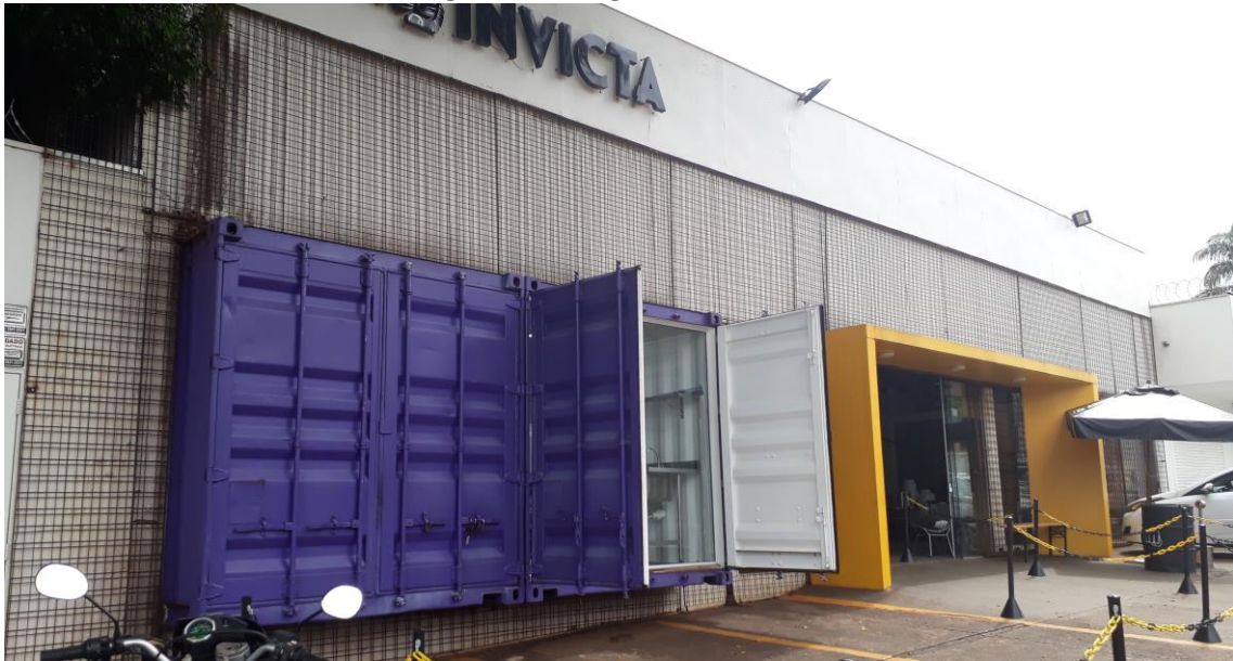
Figura 06: Imagem da fachada
