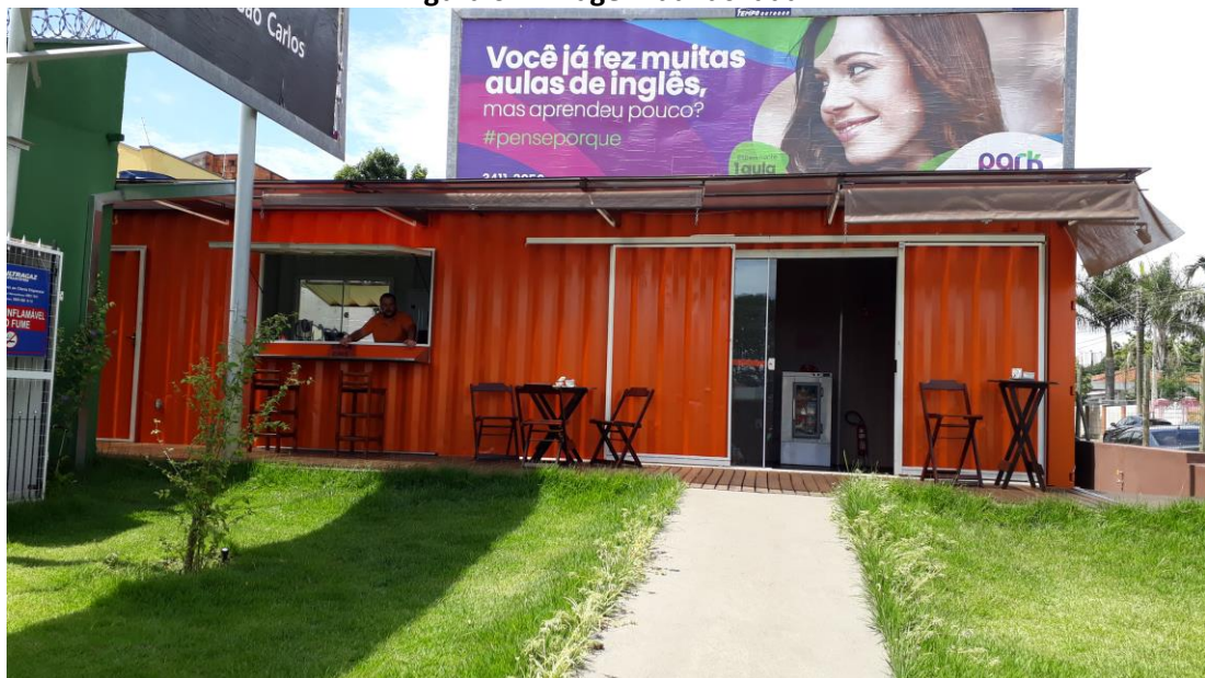
Figura 02: Imagem da fachada
