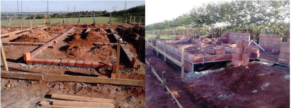
As amarrações dos pilaretes com a alvenaria foram feitas com ferro de 5,0mm dobrados em forma de “U” com 40 cm de comprimento, sendo enganchados nos ferros dos pilaretes e colocados a cada duas fiadas.
