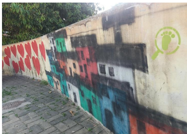
Figura 45: Muro da praça com a interferência artística realizada.
