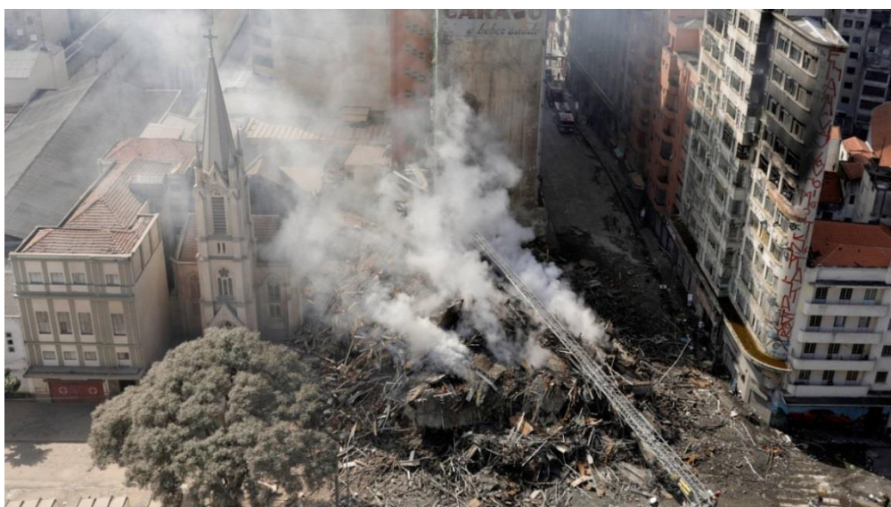
Figura 7 - Desabamento do Edifício Wilton Paes de Almeida em São Paulo, no ano de 2018
