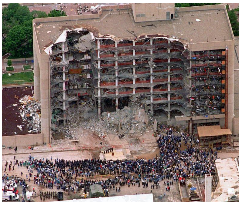
Figura 4 - Colapso do edifício Murrah Federal Building , Oklahoma no ano de 1995
