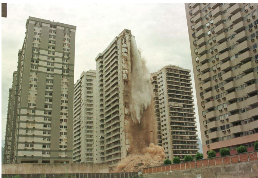
Figura 5 - Desabamento do edifício Palace II devido ao subdimensionamento de dois pilares no térreo
