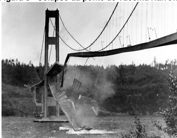
Figura 8 - Colapso da ponte de Tacoma Narrows
