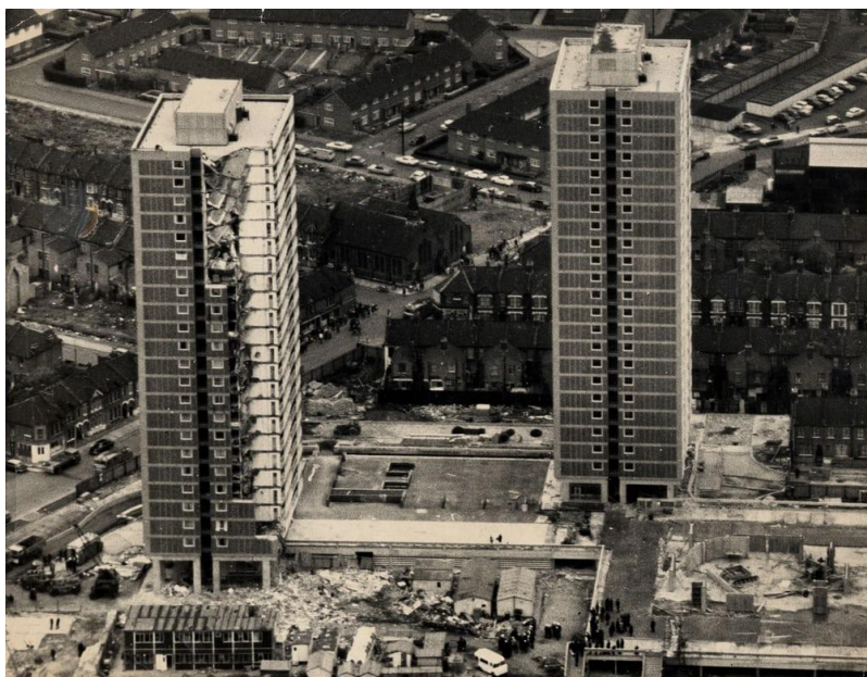
Figura 2 - Colapso da parte sudeste do edifício Ronan Point
