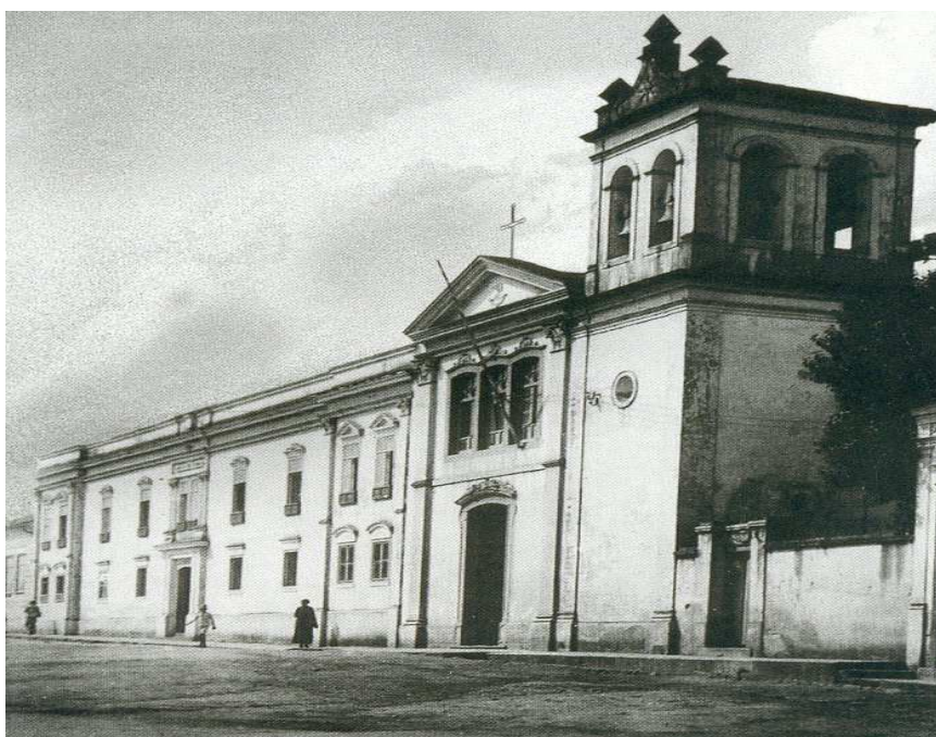
1924 – Mosteiro de São Bento e Igreja de Santa Ana. (Foto: Pedro Neves dos Santos / PRESTES, 1999)
