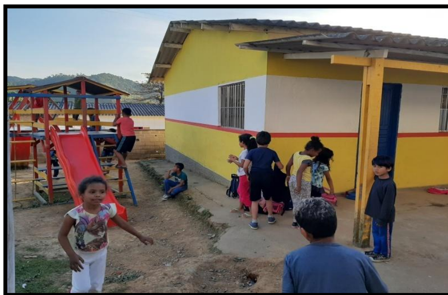
Figura 8. Escola Municipal - EMEIF Quilombo Ivaporunduva
