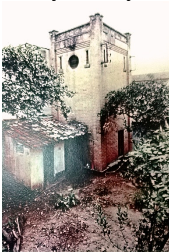
Figura 38: Imagem da antiga subestação.
