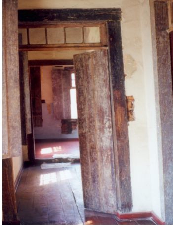
Figura 34: Restauração do corredor interno.
