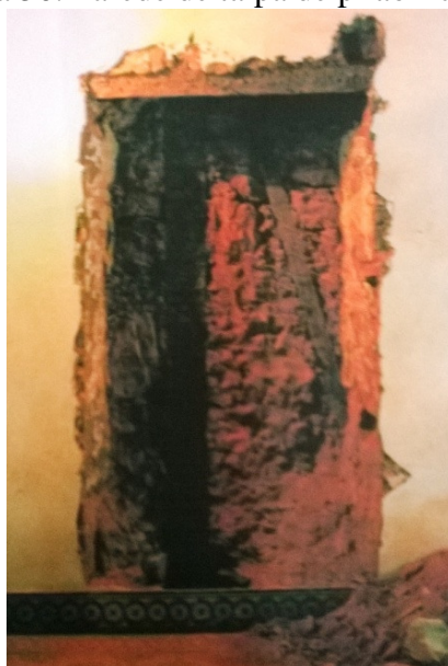
Figura 36: Parede de taipa de pilão francesa.
