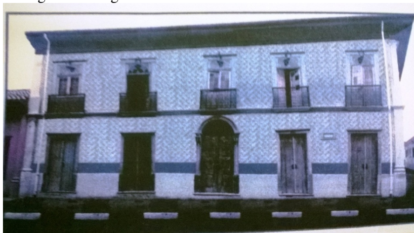
Figura 5: Imagem da fachada do sobrado antes da reforma.
