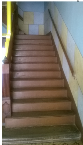
Figura 31: Escada de acesso ao piso superior.
