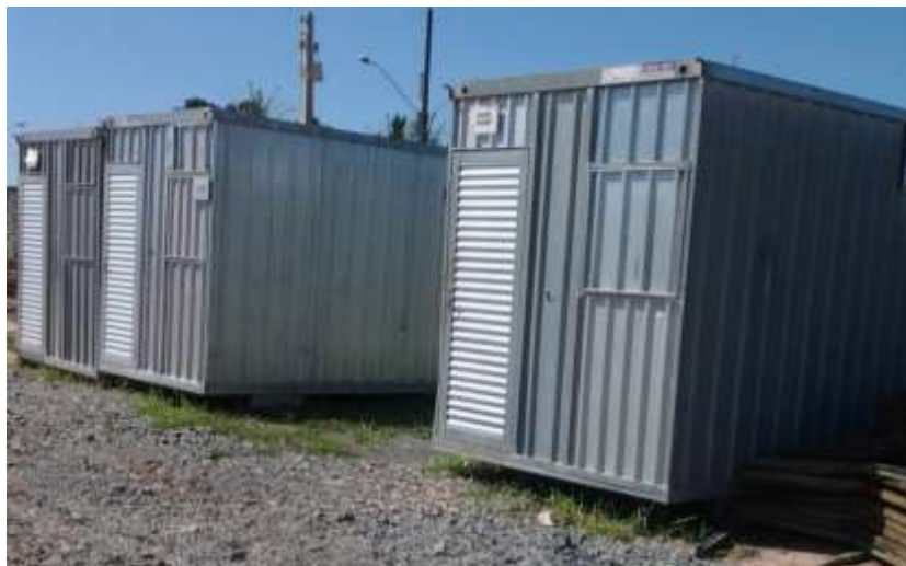
Figura 11 – Instalações provisórias em contêineres
