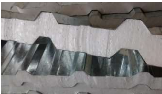
Figura 21 – Telha aço galvanizado trapezoidal termoacústica com EPS
