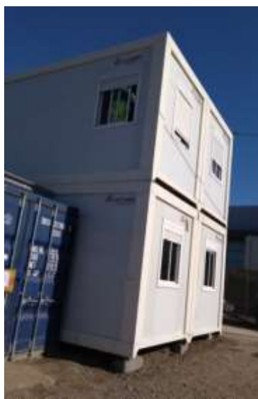
a) Contêineres tipo flat Pack empilhados utilizado para escritórios de obra
