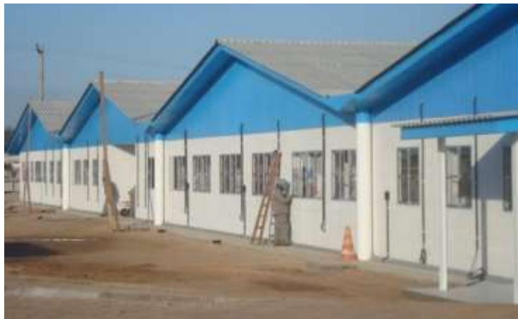
Figura 13 – Instalações provisórias em concreto celular autoclavado
