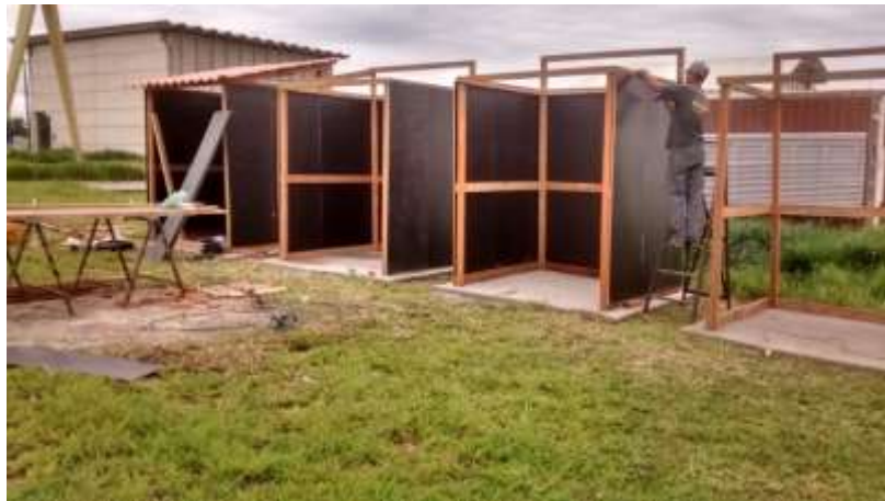
Figura 35 – Situação real de construção dos cinco protótipos de IPC
