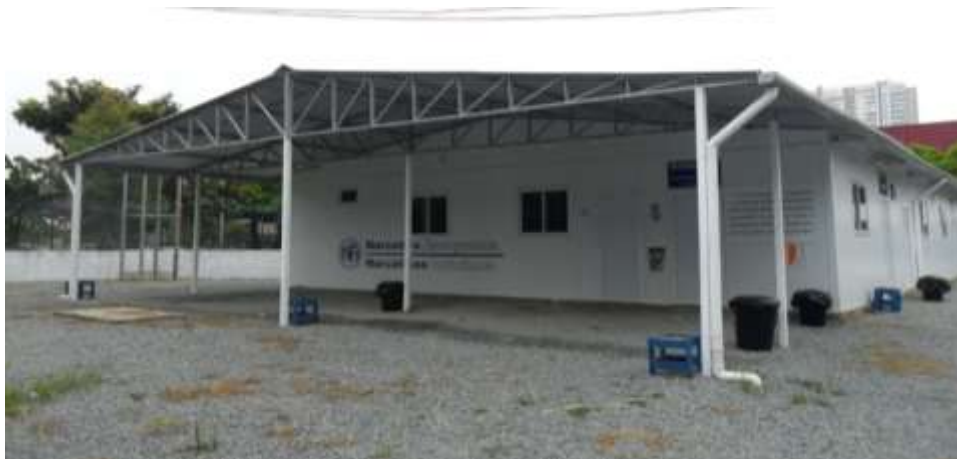
Figura 8 – Instalações provisórias de chapas metálicas
