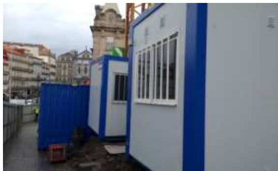
a) Contêineres à direita tipo flat Pack , azul à esquerda almoxarifado (marítimo)
