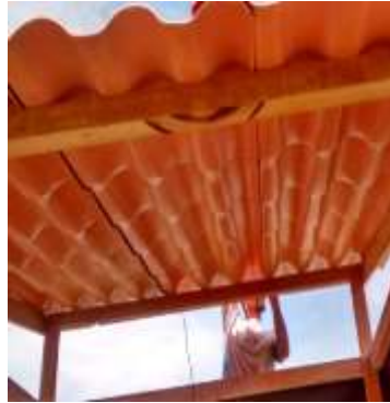
b) Telha de PVC formato colonial. Utilizou-se 3 chapas para cobertura
