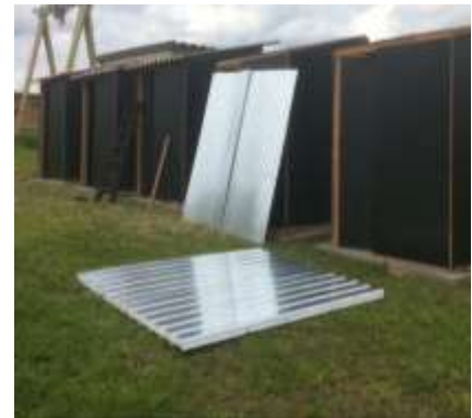
c) Instalação das telhas em aço galvanizado ondulada e termoacústica (2 chapas)
