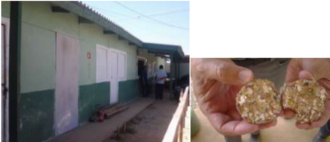
Figura 9 – Instalações Provisórias de chapas recicladas
