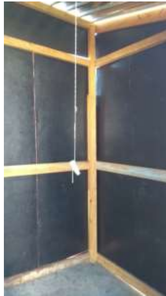
a) Logger dentro da IPC para registro da temperatura e umidade
