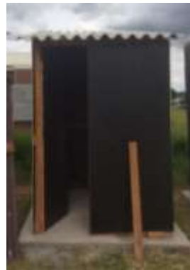
b) Telha de fibrocimento ondulada em instalação (2 chapas)
