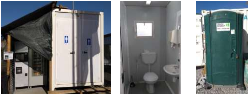
a) Banheiro externo contêiner tipo flat Pack – canteiro 1
