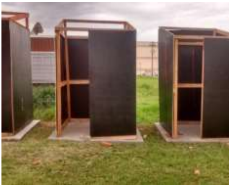
a) Piso cimentado, estrutura em madeira e fechamento
