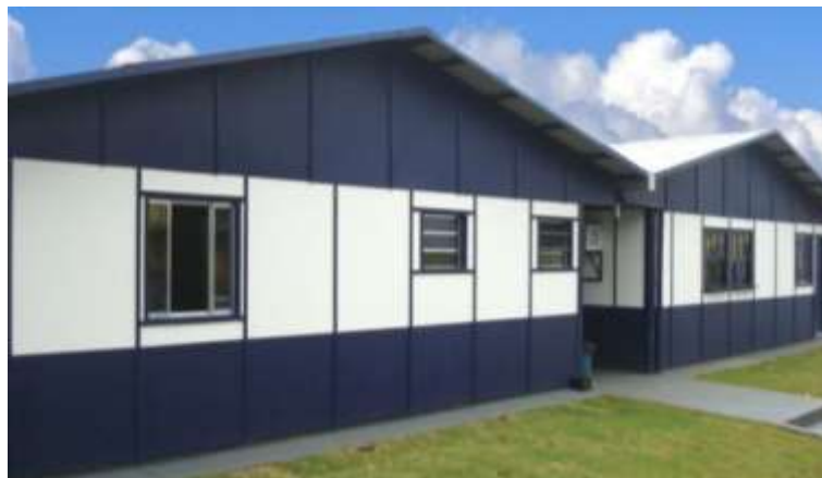
Figura 7 – Instalações provisórias de chapas compensada de madeira
