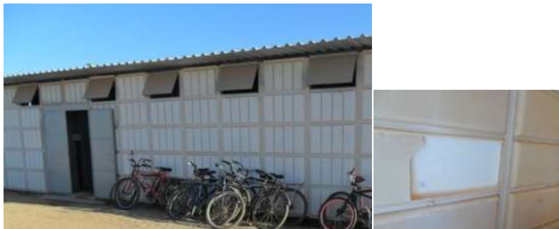
Figura 12 – Instalações provisórias em polietileno reciclado
