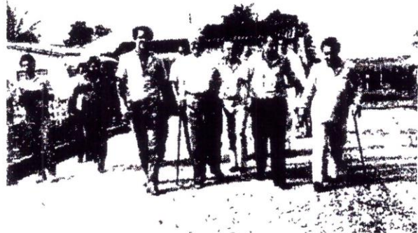
O governador Julio Campos inspecionou as obras de pavimentação em Pedra Preta.
