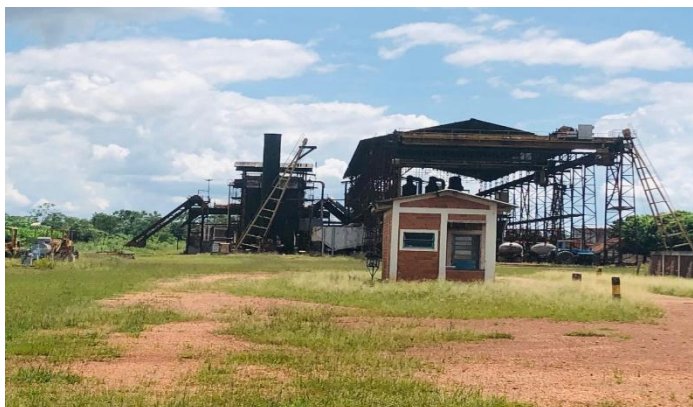
Foto 14 - Lado direito da usina, próximo à guarita de acesso, com a presença de construções
