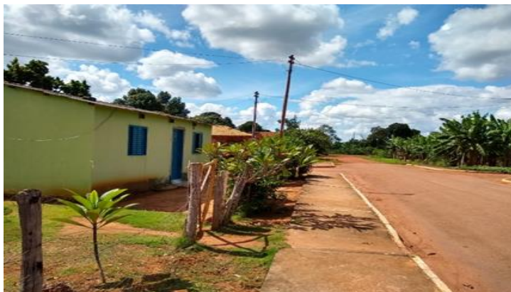
Foto 7 - Asfaltamento de rua: aspecto de modernidade na comunidade
