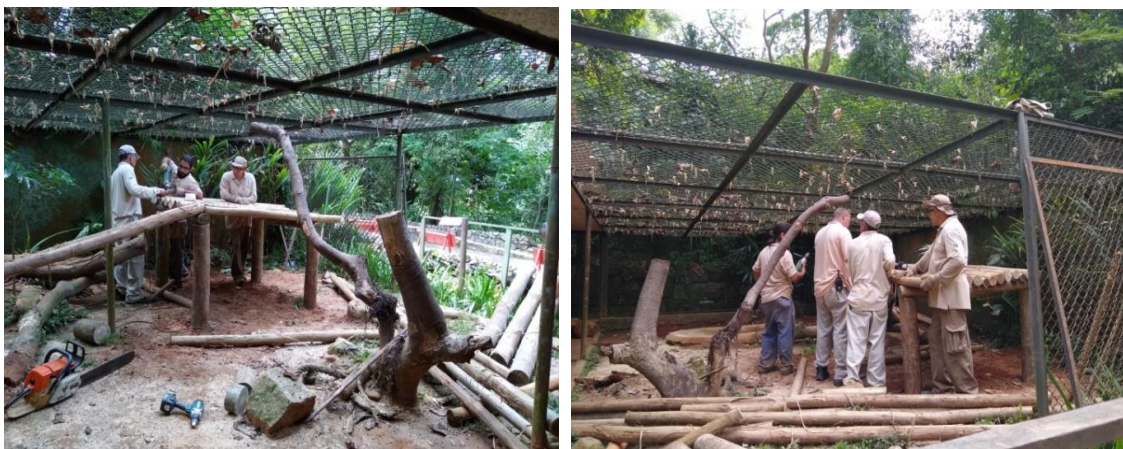
Figura 15 – Equipe do Setor de Estrutura e Manutenção da FPZSP realizando a ambientação do recinto de H. yagouaroundi . Foto: Arquivo pessoal.
