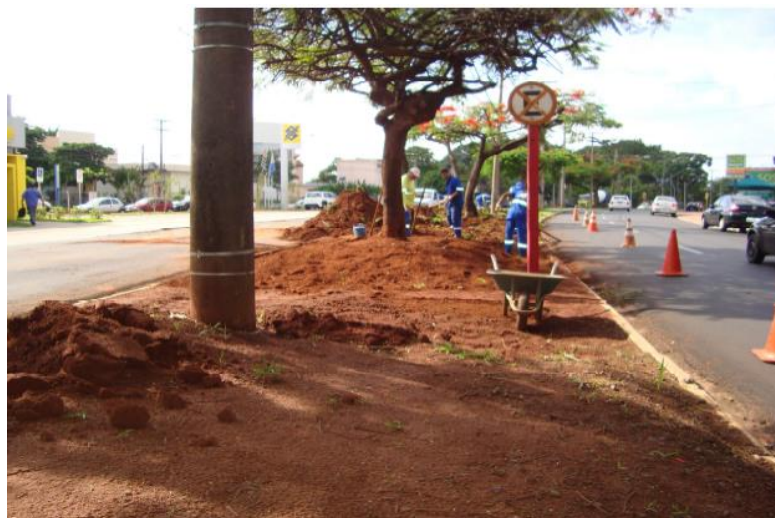
Figura 36: Intervenção realizada no canteiro da Av. Napoleão Selmidey em Araraquara - 2017.
