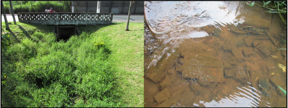
Figura 42 – Leito do córrego Água Branca no centro urbano. Fonte: Autora (2019).
