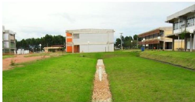
Trincheira de infiltração
