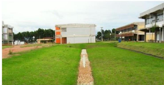
Trincheira de infiltração
