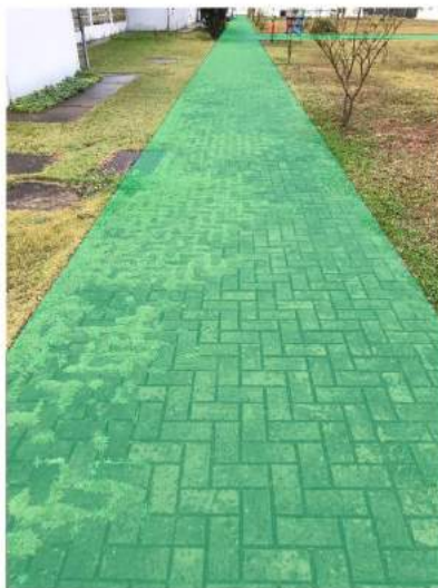
Figura 3 - Piso intertravado utilizado em passeio para pedestres, no campus da UFSCar, em São Carlos/SP.
