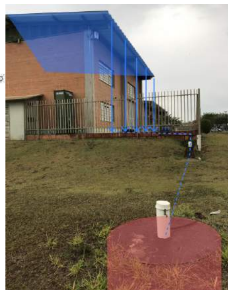
Figura 20 – Poço de infiltração I após três anos de sua implantação, no campus da UFSCar, em São Carlos/SP.
