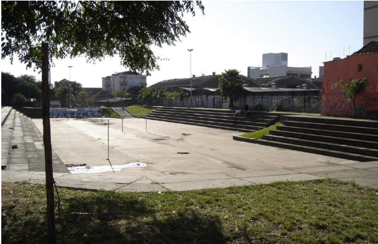
Figura 6 - Bacia de retenção (seca) com função de área pública de lazer e retenção de águas pluviais, em Porto Alegre/RS.
