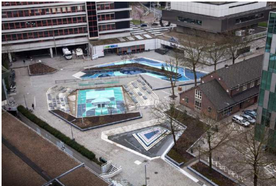
Figura 5 – Water Plaza Benthemplein , em Roterdã, Holanda.
