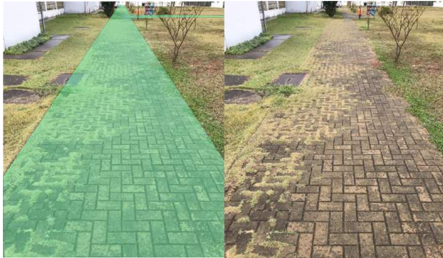
Figura 17 – Piso intertravado utilizado em passeio para pedestres, no campus da UFSCar, em São Carlos/SP.
