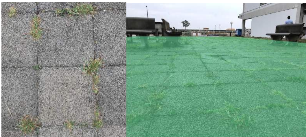
Figura 18 – Piso de concreto drenante em área de descanso, no campus da UFSCar, em São Carlos/SP.
