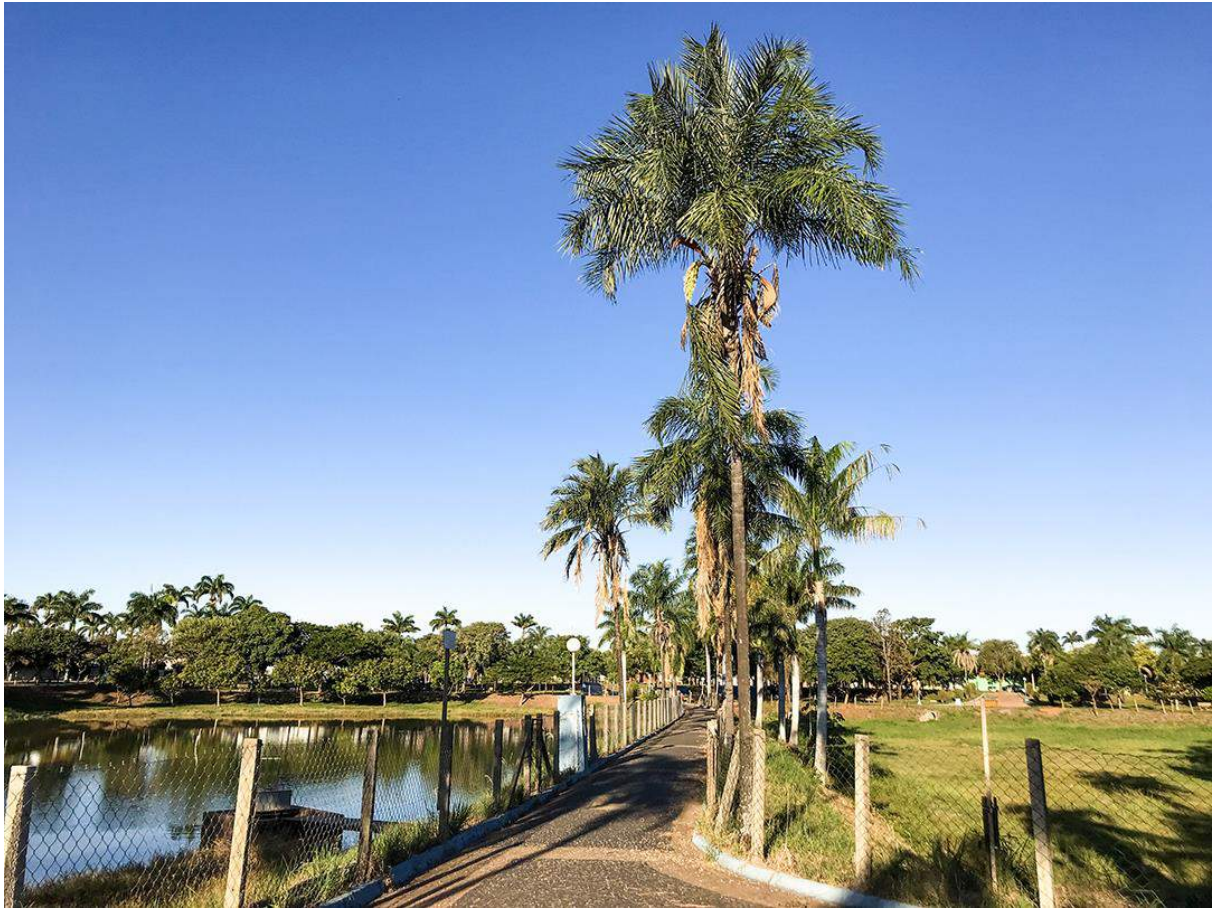
Figura 55 - Bacias de retenção (molhada) e detenção (seca) na Praça do Trabalhador, em Guararapes/SP.
