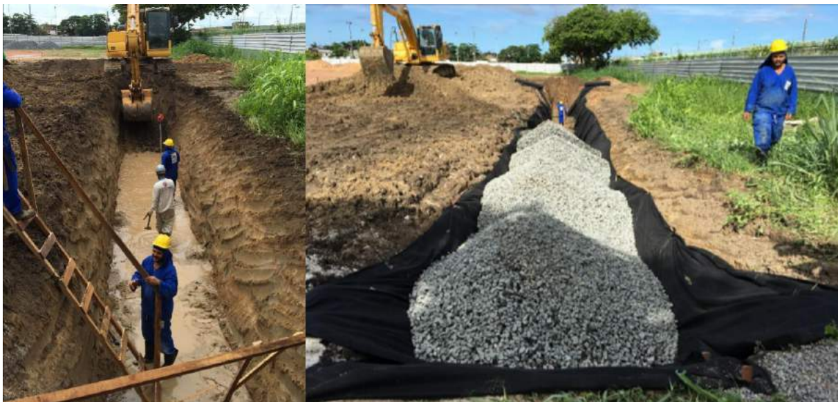
Figura 8 – Construção de trincheira de infiltração, em Recife/PE.
