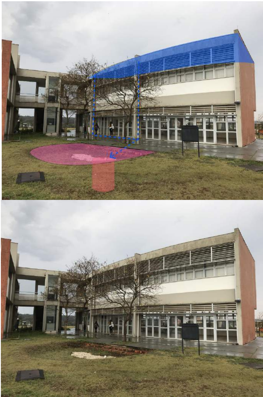
Figura 23 – Plano-poço de infiltração após quatro anos de sua implantação, no campus da UFSCar, em São Carlos/SP.
