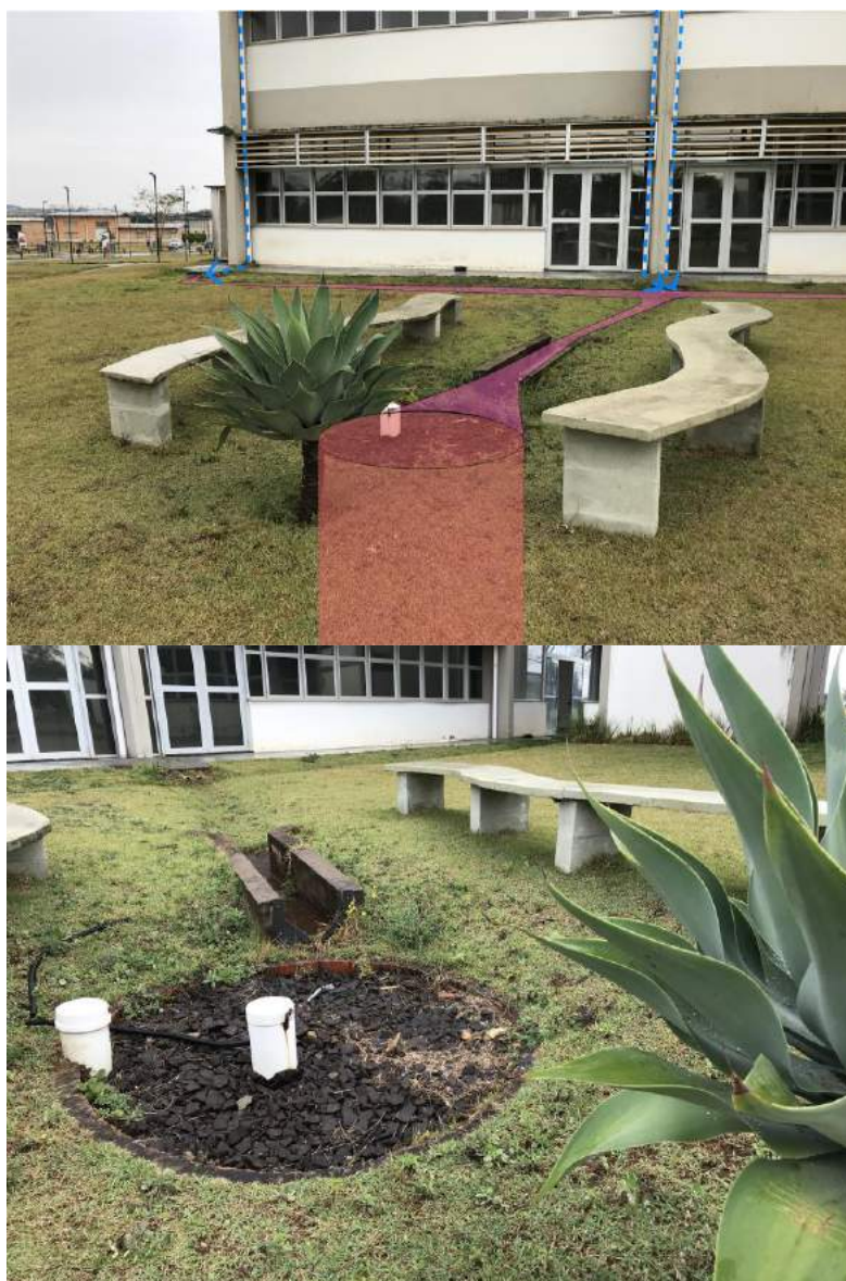
Figura 25 – Valeta-poço de infiltração após sete anos de sua implantação, no campus da UFSCar, em São Carlos/SP.
