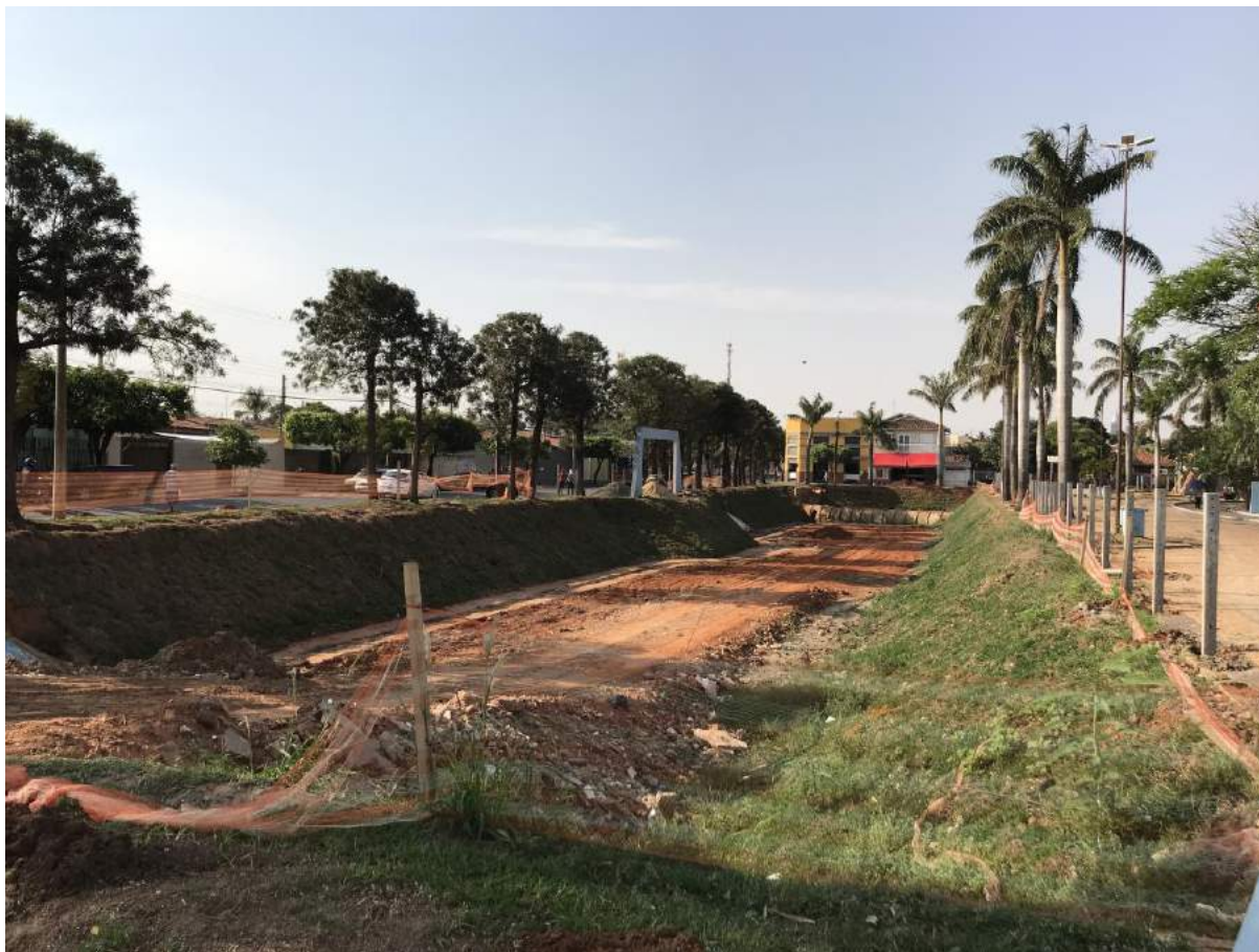
Figura 62 - Bacia de detenção (seca) em construção, também na Praça Mohamed Dargham, em Guararapes/SP.
