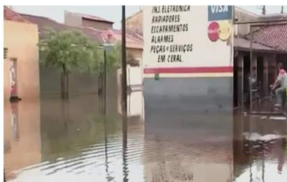
Figura 3 – Nível d'água elevado, atingindo a fachada dos edifícios, após chuva de 19 de janeiro de 2017, em Guararapes/SP (De Olho No Tempo, 2017).
