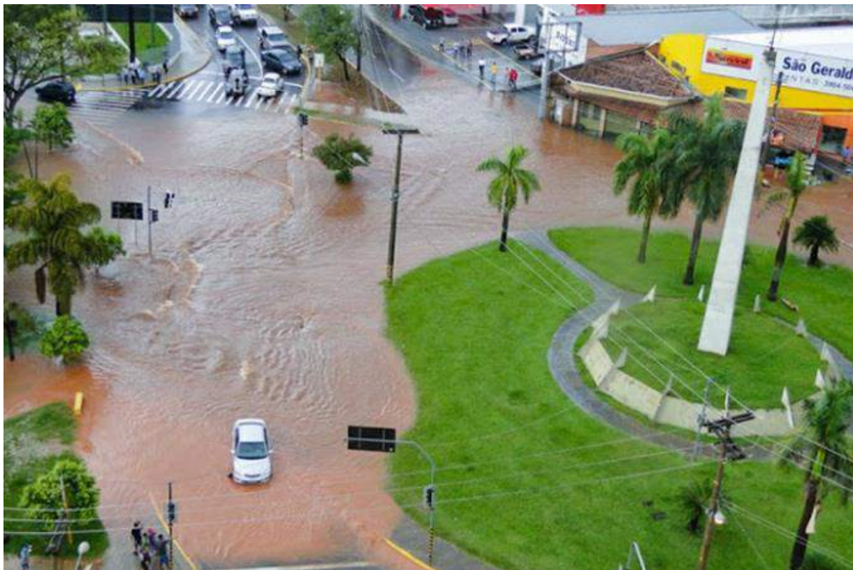
Figura 3 - Alagamento sobre córrego canalizado e tamponado, em Presidente Prudente/SP.
