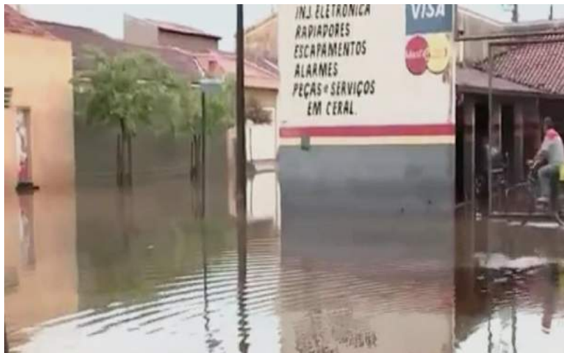
Figura 47 – Nível d'água elevado, atingindo a fachada dos edifícios, após chuva de 19 de janeiro de 2017, em Guararapes/SP.
