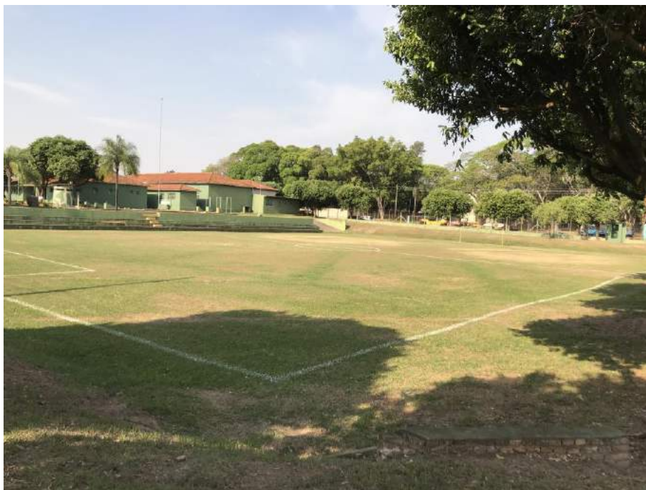
Figura 54 - Bacia de detenção (seca) no Tiro de Guerra, em Guararapes/SP.
