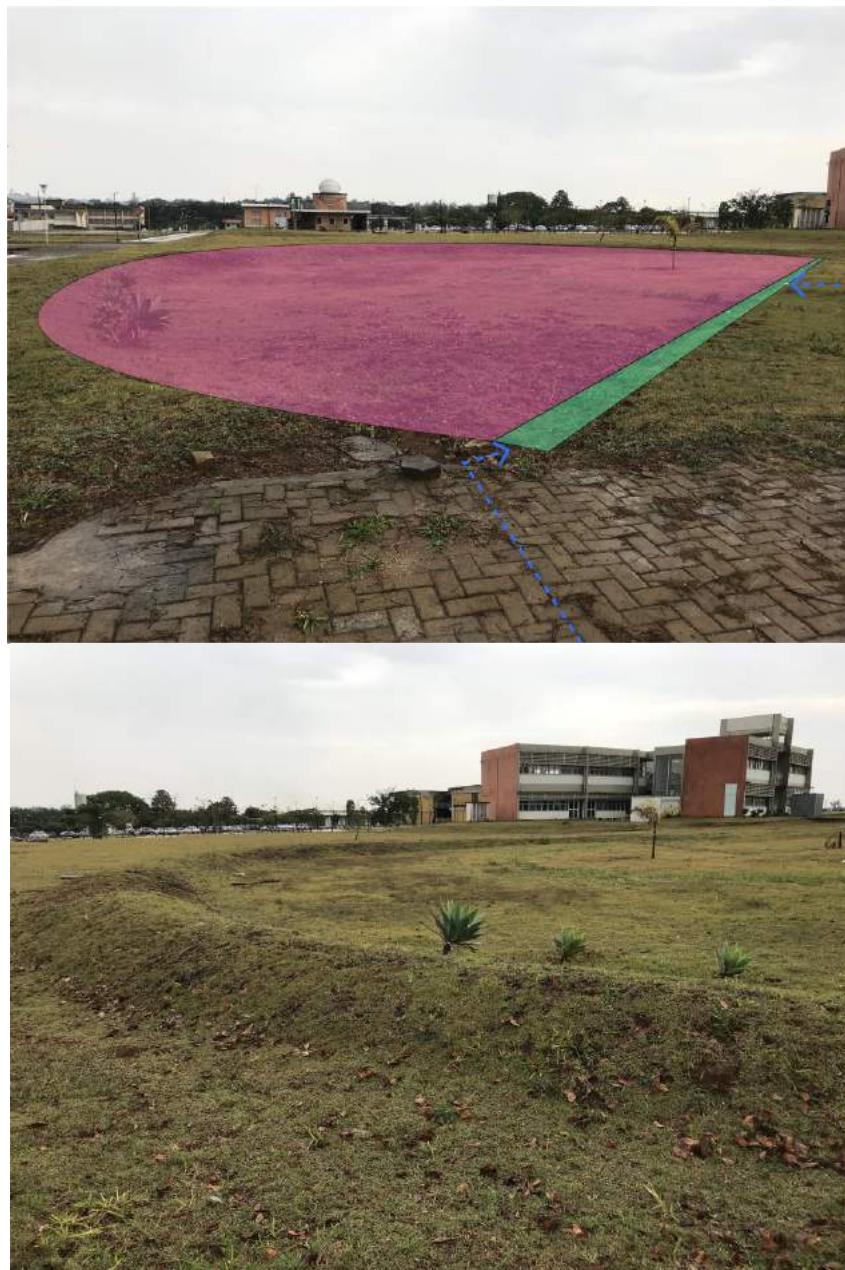
Figura 13 - Plano de infiltração 2 após, aproximadamente, cinco anos de sua implantação pelo G-HIDRO, no campus da UFSCar, em São Carlos/SP.
