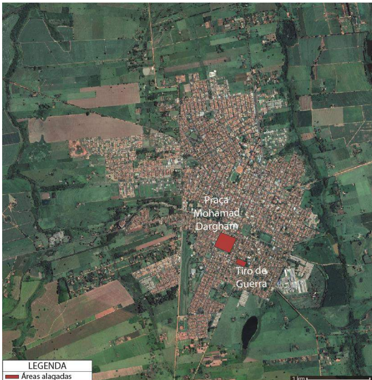
Figura 49 - Áreas relatadas como alagadas nos eventos hidrológicos dos anos de 2017 e 2020 em Guararapes/SP.
