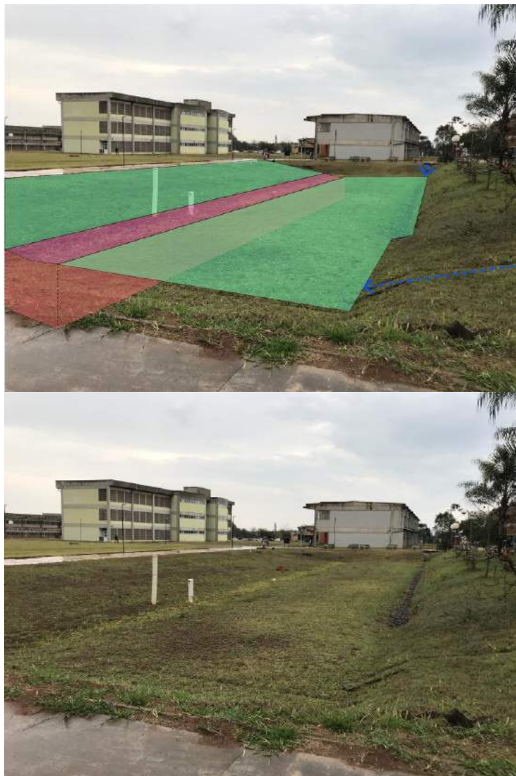
Figura 10 - Filtro-vala-trincheira oito anos após sua implantação pelo G-HIDRO, no campus da UFSCar, em São Carlos/SP.
