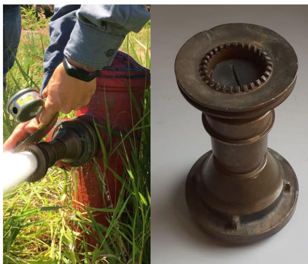
Figura 8 – Hidrante com o esguicho regulável de 2" ½ acoplado
