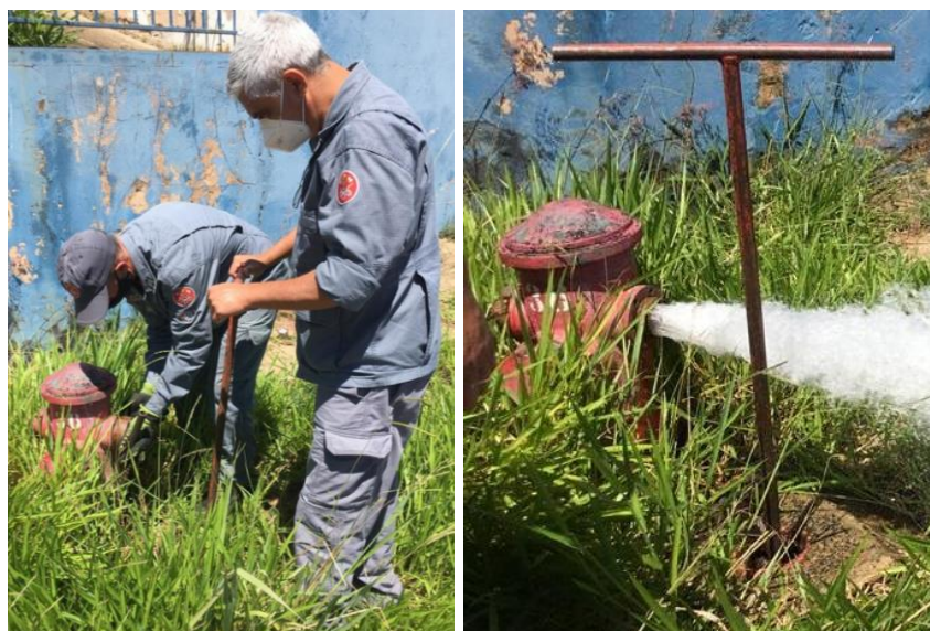
Figura 6 – Abertura da Válvula utilizando a chave T
