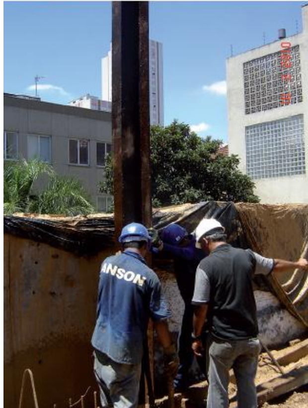
Figura 30 – Colocação do perfil junta para concretagem
