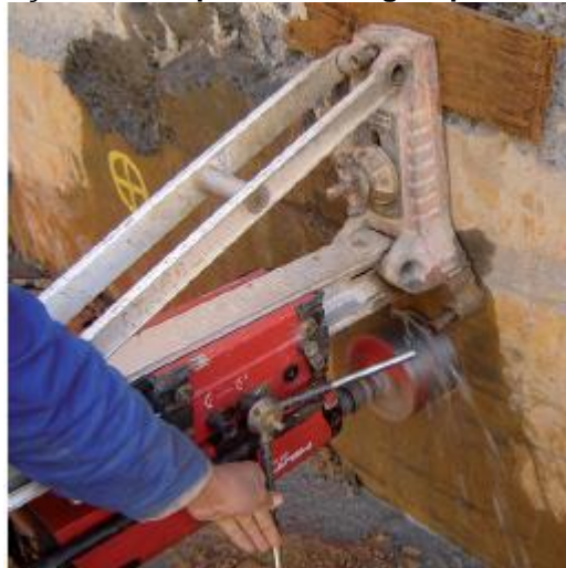
Figura 6 – Perfuração de uma parede diafragma para instalação de tirante
