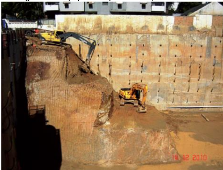
Figura 33 – Rampa para remoção da escavação em andamento
