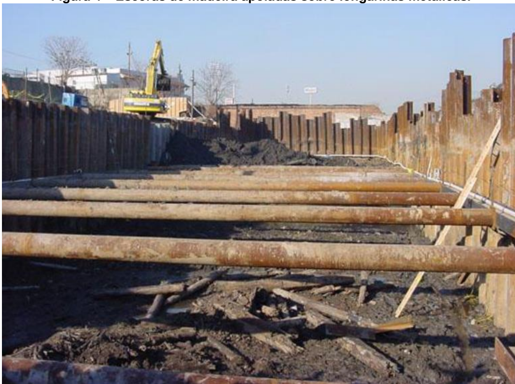
Figura 4 – Escoras de madeira apoiadas sobre longarinas metálicas.
