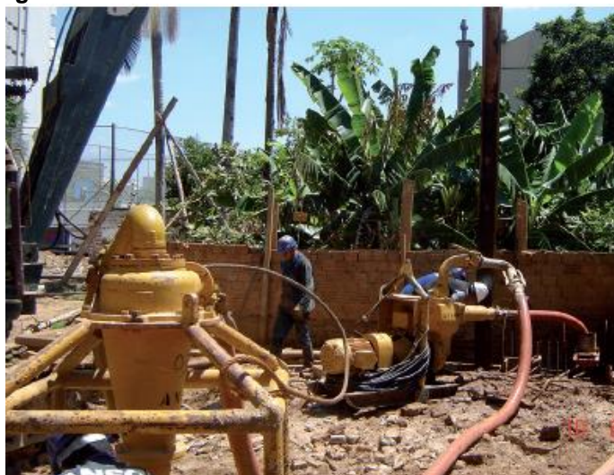
Figura 23 – Bomba e desarenador de fluido estabilizante
