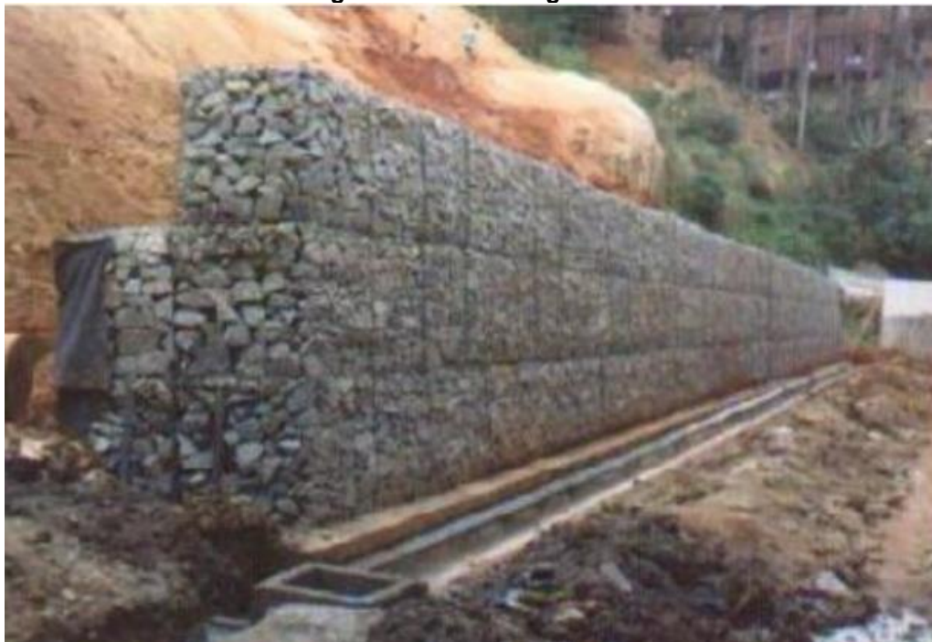
Figura 13 – Muro de gabiões
