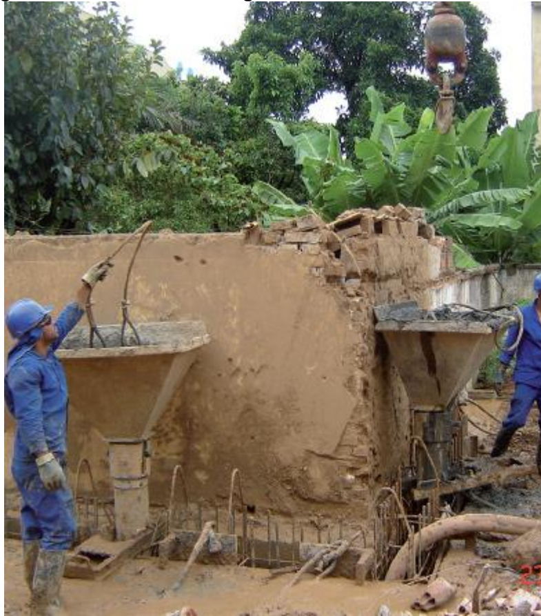
Figura 29 – Funis de concretagem conectados aos tubos tremonha
