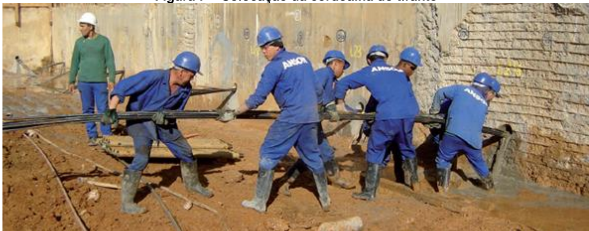
Figura 7 – Colocação da cordoalha do tirante
