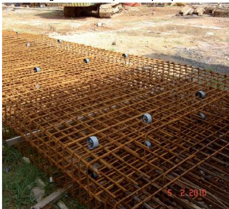
Figura 28 – Colocação da chapa espelho
