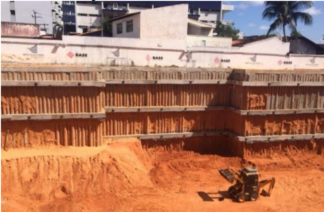
Figura 42 – Cortina de estacas atirantada
