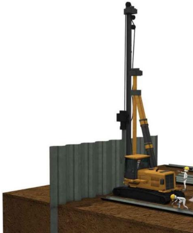
Figura 17 – Estacas-prancha metálicas
