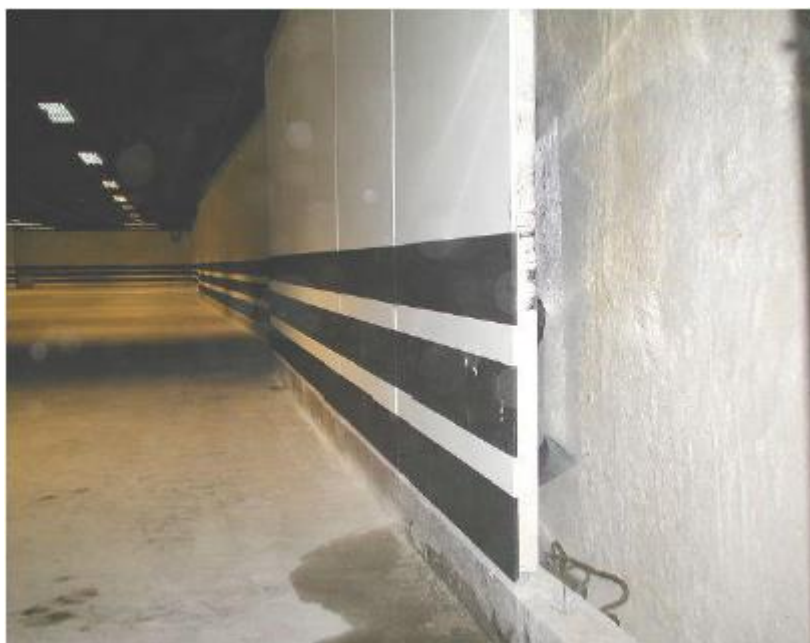
Figura 51: Parede dupla com canaleta de drenagem
