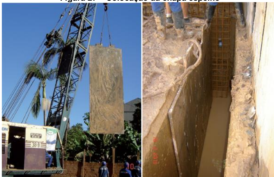
Figura 27 – Colocação da chapa espelho
