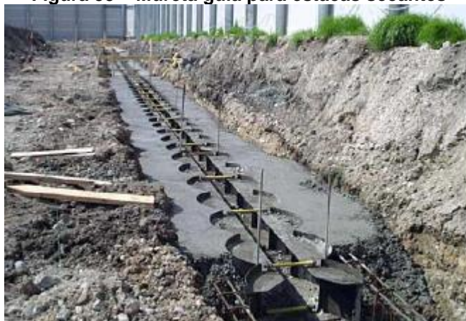
Figura 35 – Mureta guia para estacas secantes
