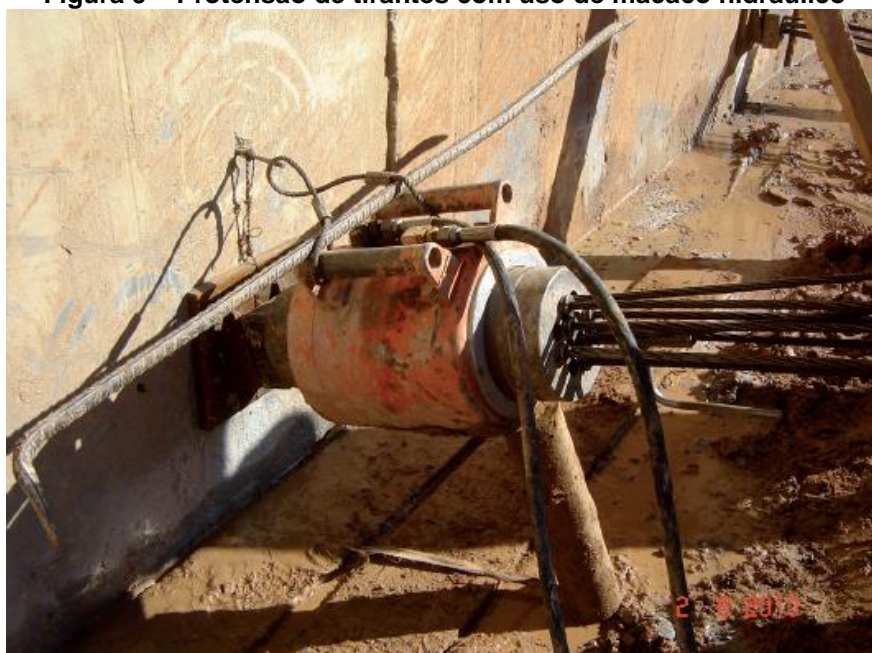
Figura 9 – Protensão de tirantes com uso de macaco hidráulico
