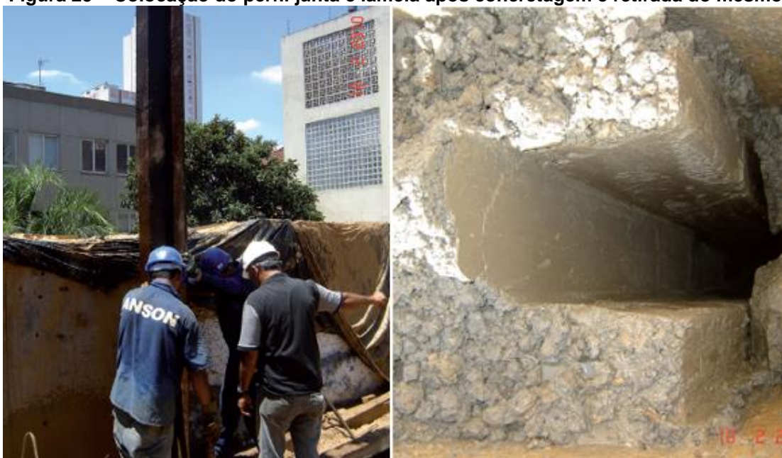
Figura 25 – Colocação do perfil junta e lamela após concretagem e retirada do mesmo
