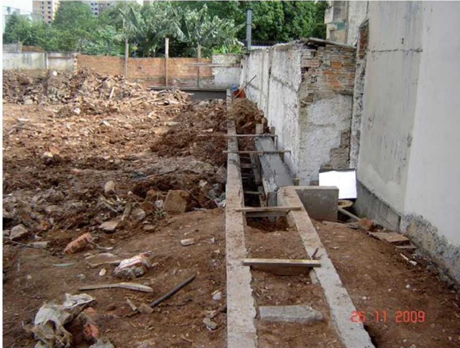
Figura 20 – Execução da parede guia
