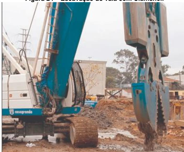
Figura 24 – Escavação de vala com Clamshell
