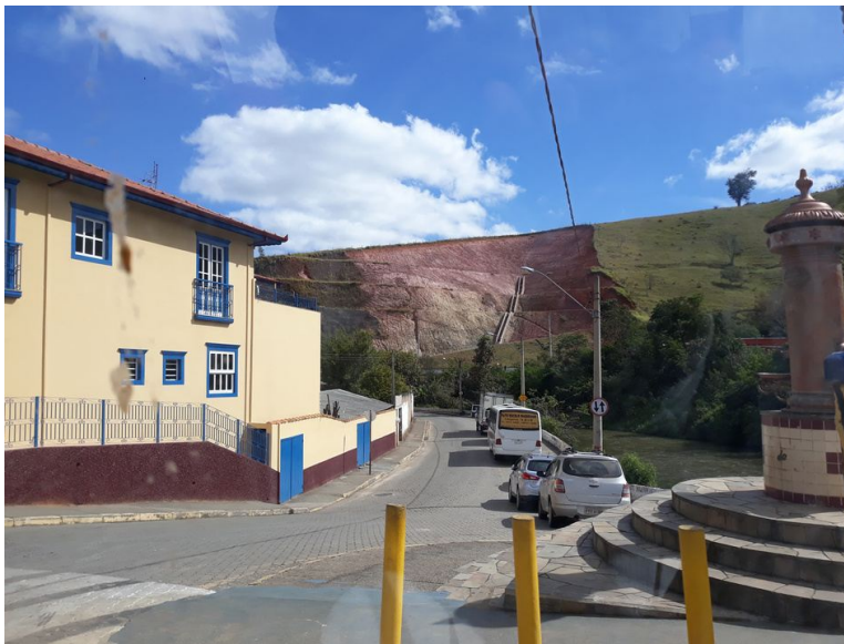
Figura 12: deslizamento de terra em solos das margens do rio Paraitinga, (2019). Fonte: Pedro Zanette.
