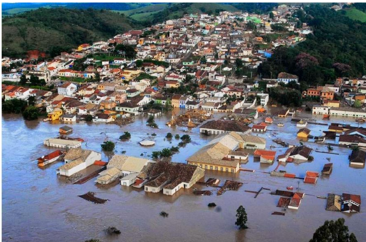
Figura 2: Vista aérea do centro histórico, no pico da enchente, após a queda da Igreja Matriz, no dia 2 de janeiro de 2010. Fonte: Arquivo Defesa Civil Municipal
