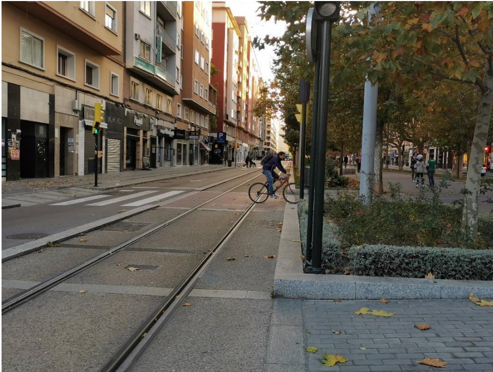
Figura 129: Paseo de la Gran Vía , detalhe do nivelamento do piso para o pedestre.
