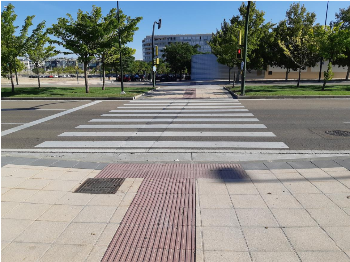
Figura 150: Travessia Av. de Casablanca, Valdespatera.
