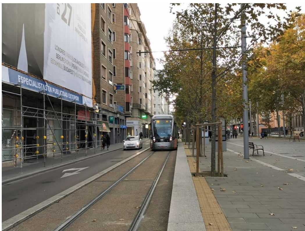
Figura 112: Paseo de la Gran Vía , desnível para separar modais.
