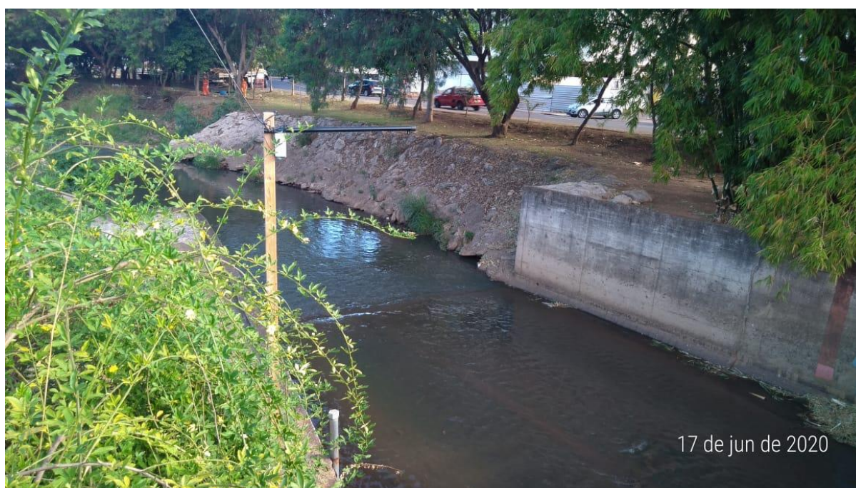
Figura 38 - Exemplo de instalação de uma estação de monitoramento
