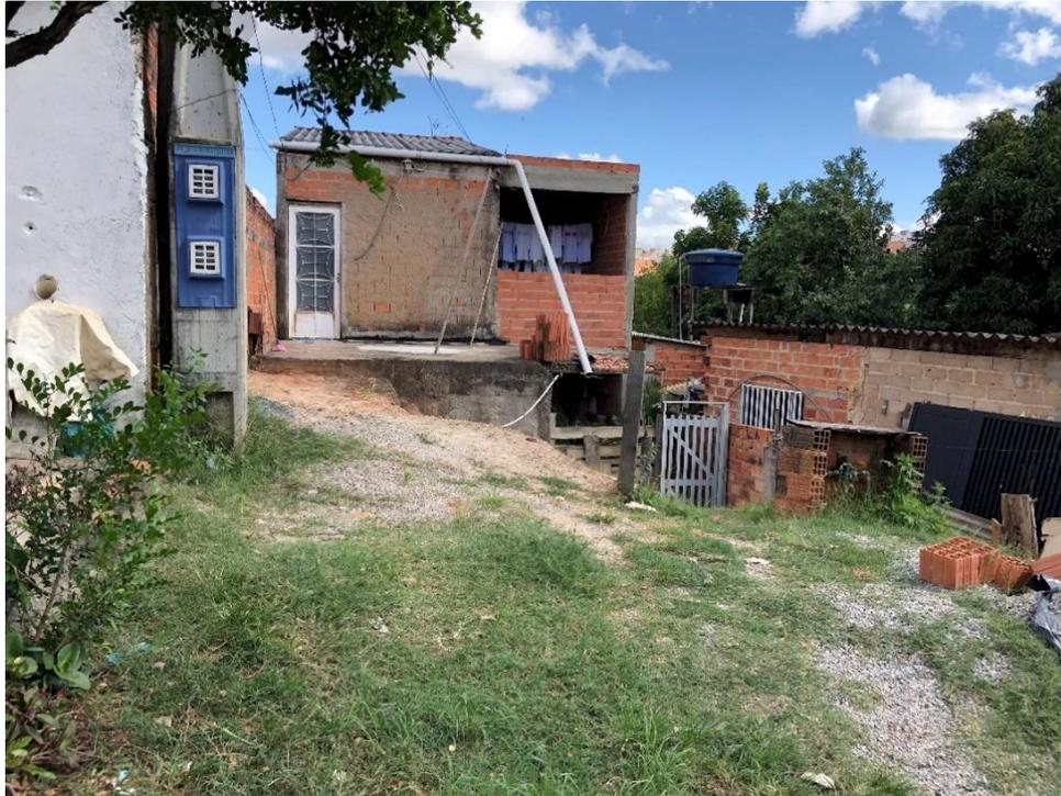
Chama-se atenção para a inexistência de revestimento nas paredes externas, utilização de telhas de fibrocimento/*Eternity*, tubulação exposta. Fonte: (Acervo pessoal. 2019).
