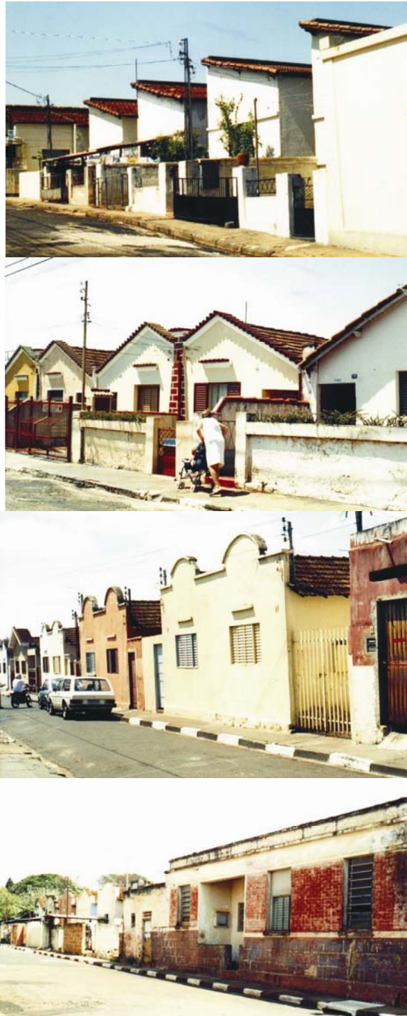
Fig. 42 a 45: Casas na Rua Silveira Martins, nos Campos Elíseos, na Travessa Cantareira, na Travessa Paterlini, e na Rua Acre, no Ipiranga (Foto da autora).
