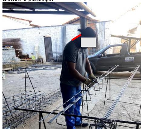
Posicionamento dos estribos: nessa etapa o armador fica com pescoço inclinado todo o tempo para posicionar e amarrar o estribo na marcação indicada.
