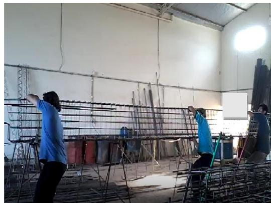
Transporte da armadura para o local de estoque: essa etapa demanda dos armadores grande esforço físico, além de posturas inadequadas, como ratação do tronco e pescoço.
