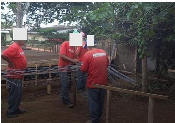
Marcação de barras é uma etapa em que o trabalhador precisa de atenção para garantir o espaçamento dos estribos. Por esse motivo, ao longo da marcação, o trabalhador fica com o pescoço inclinado todo o tempo.
