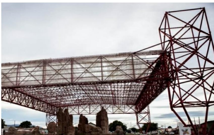
Figura 36: Ruínas da Igreja Matriz, com intervenção na cobertura
