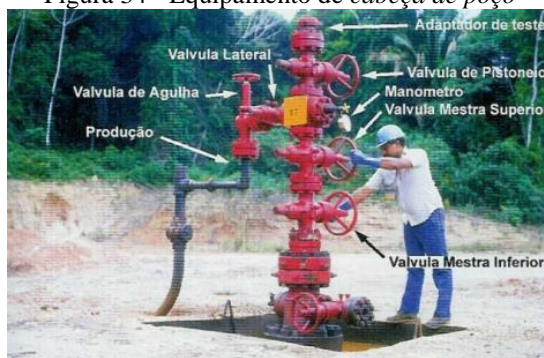
Figura 34 - Equipamento de cabeça de poço
