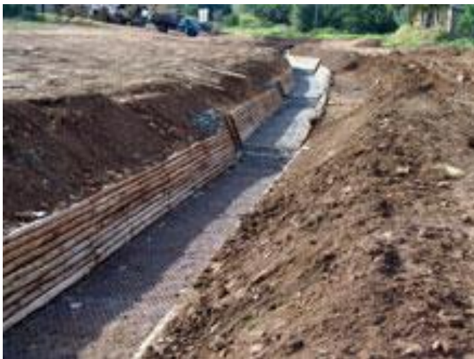
Figura 3.5 - Taludamento das encostas do córrego
