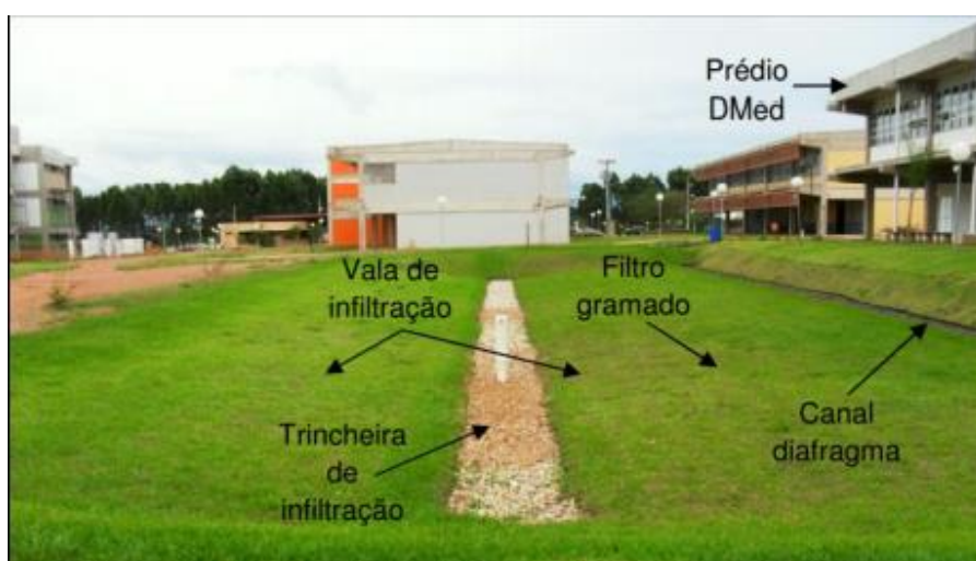
Figura 2.14 - Filtro-vala-trincheira de infiltração
