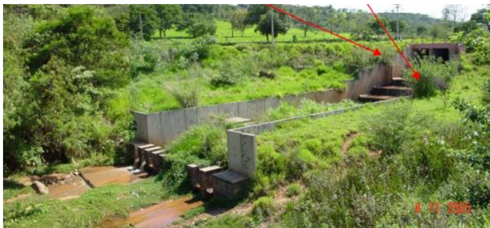
Figura 3.8 - Dissipador de energia construído no Córrego da Água Quente
