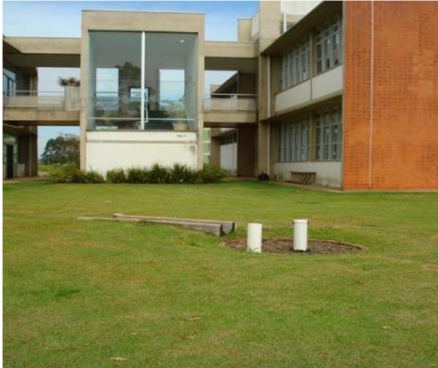
Figura 2.15 - Poço de infiltração
