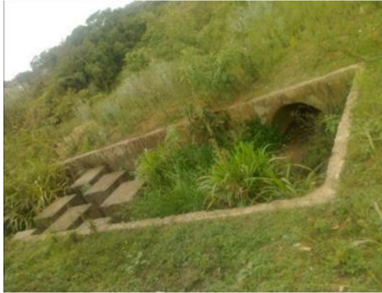
Figura 3.10 - Dissipador de energia
