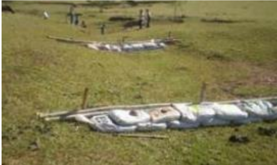
Figura 4.23 - Barreiras feitas com sacos de areia e seixos apoiadas em bambu
