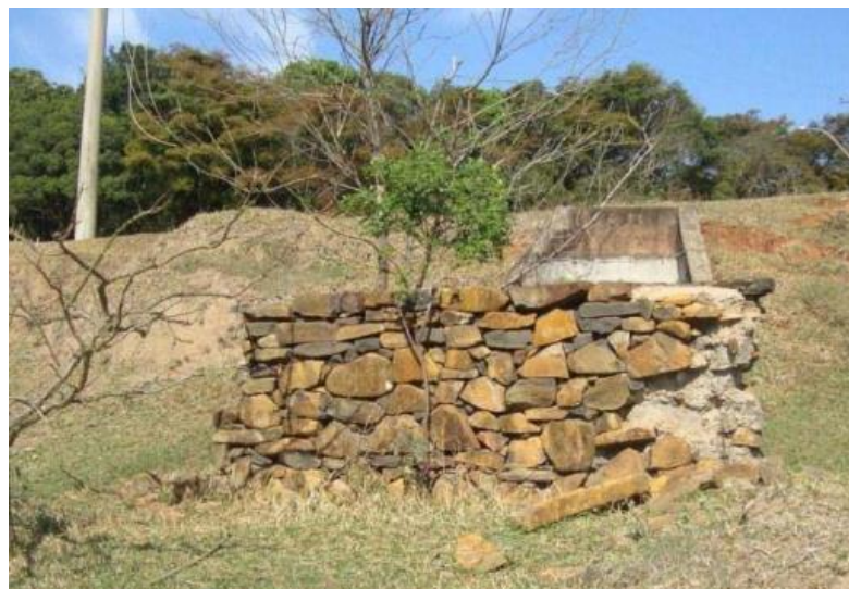
Figura 4.16 - Muro de contenção na saída de tubulação
