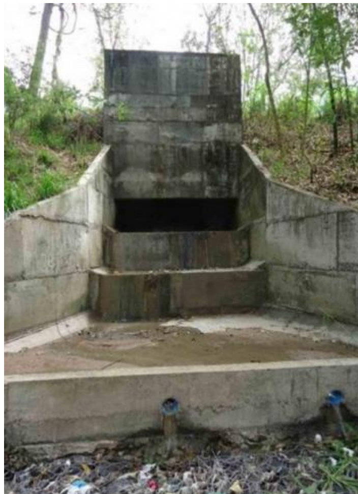
Figura 3.11 - Dissipador de energia
