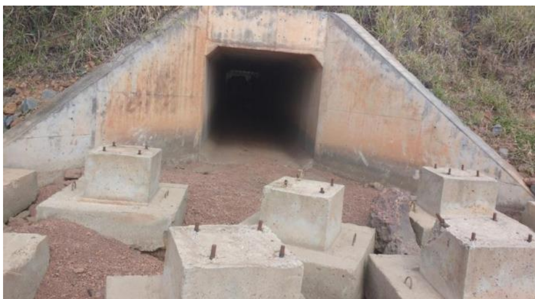
Figura 4.11 - Galeria com dentição de concreto
