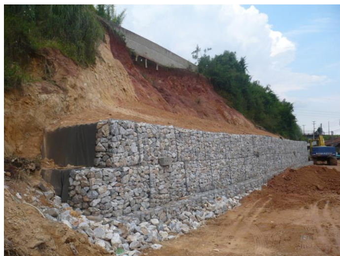
Figura 2.6 – Muro de Gabião
