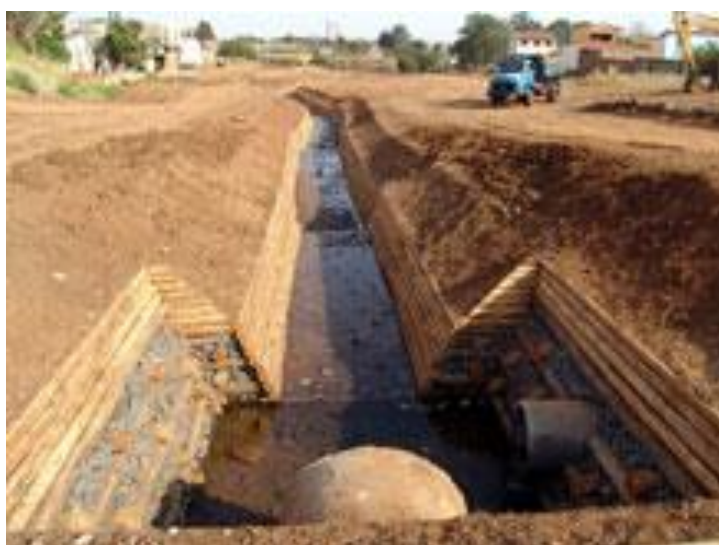
Figura 3.4 - Obra de recuperação do Tijuco Preto
