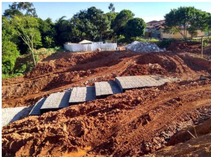
Figura 4.9 - Execução de gabião
