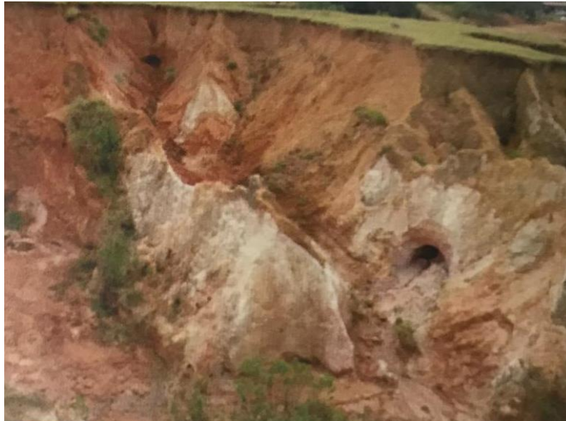
Figura 2.1 - Erosão interna (“piping”) em voçoroca
