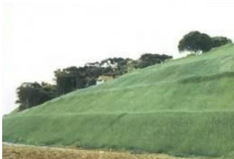
Figura 4.1 - Talude com aplicação de hidrossemeadura
