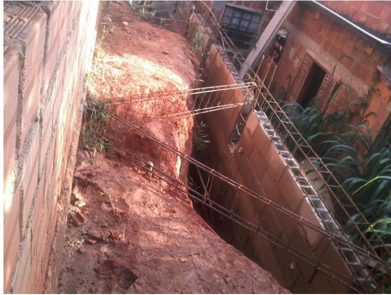
Figura 2.7 – Muro de Contenção
