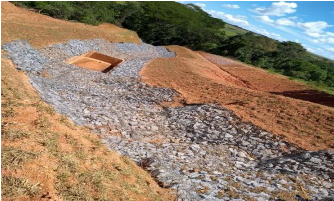
Figura 4.13 - Lineamentos das bordas da Voçoroca, aterramento e instalação de degraus com pedras amarradas, cobertas por tela de gabião para fixá-las e caixas de contenção
