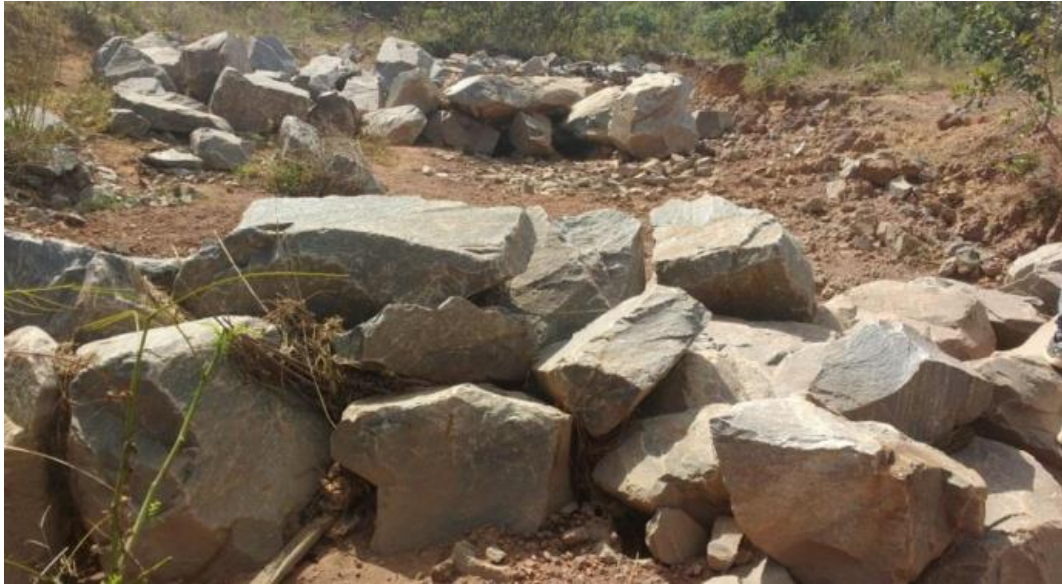
Figura 4.12 - Barreira de blocos de gnaiss
