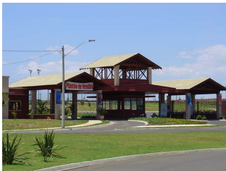
Portaria do “Residencial Montreal” Foto: Osny Pellegrino Ferreira (2003)
