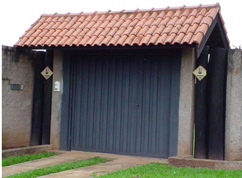
Placas de advertência em fachada de residência no “Parque Fehr” Foto: Francisco Barnabé Ferreira (2007)
