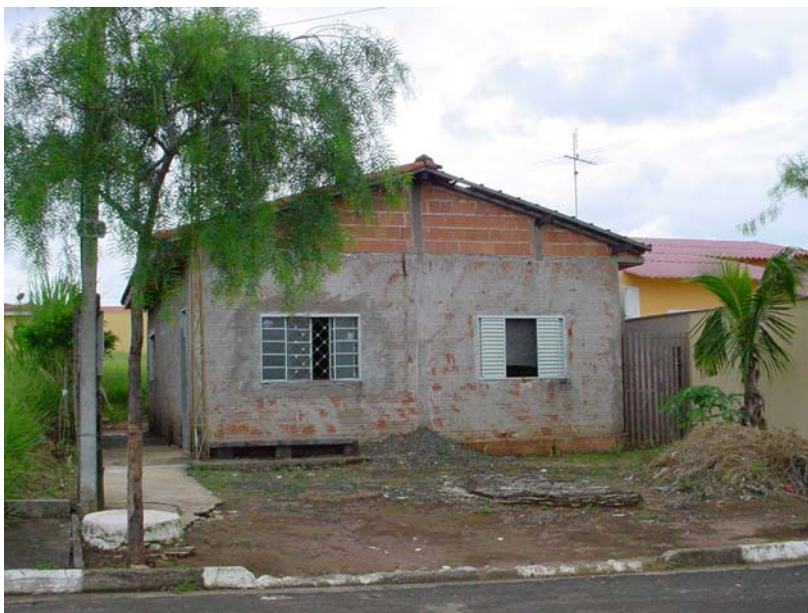
Residência inacabada no “Parque Fehr”: além da heterogeneidade sócio-econômico-cultural, a ausência de normas construtivas também contribui para este fator Foto: Francisco Barnabé Ferreira (2007)
