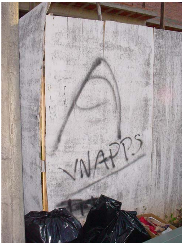
Tapume de obra pixado no “Parque Faber I” Foto: Francisco Barnabé Ferreira (2005)
