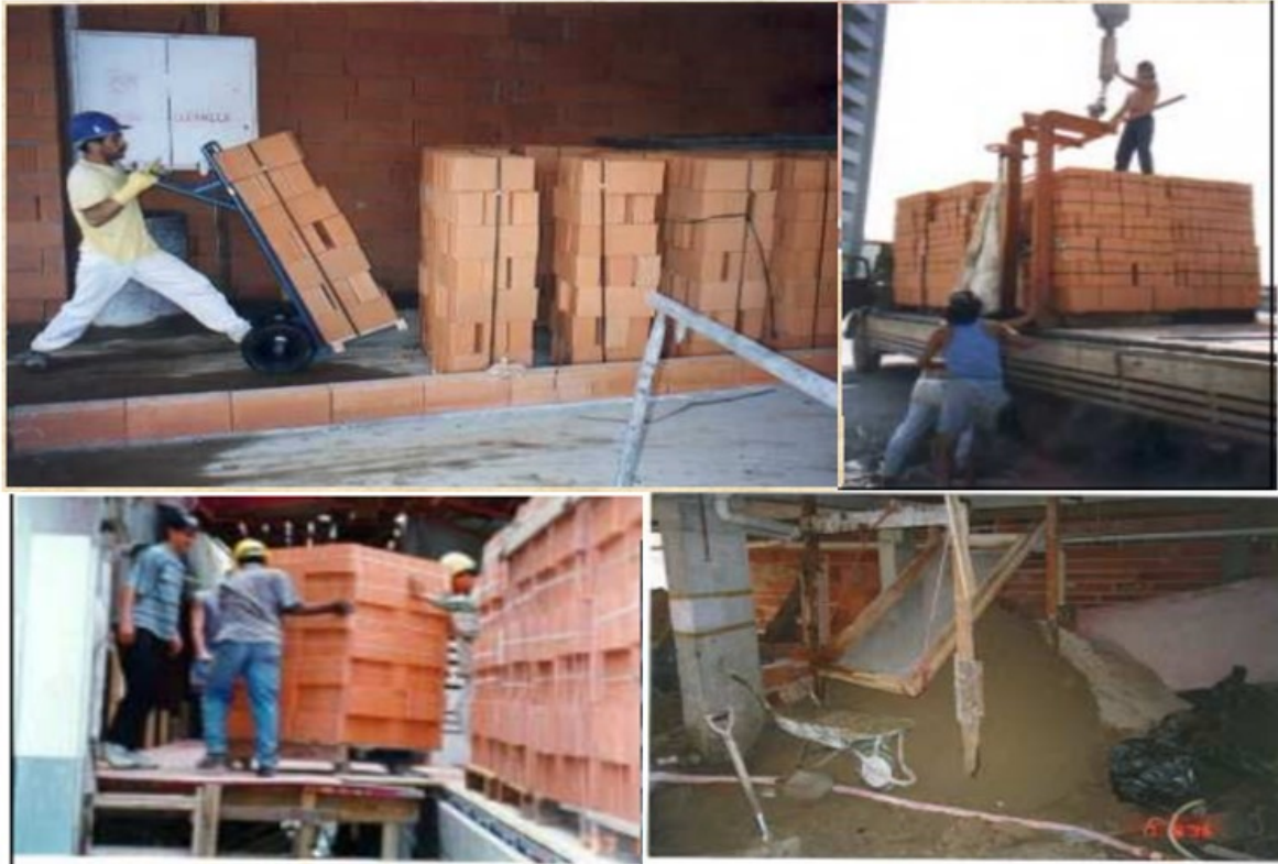
Figura 13 - Estoque de materiais de forma correta para evitar desperdício na fase 2
