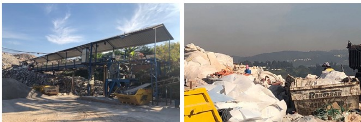
Figura 21 - Área de descarte na fase 4
