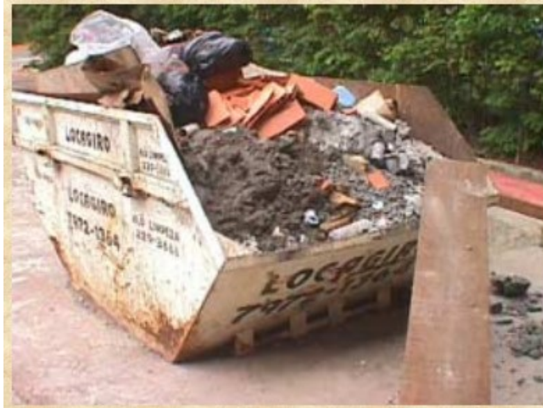
Figura 19 -Materiais retirados não utilizáveis na caçamba de entulho na fase 4
