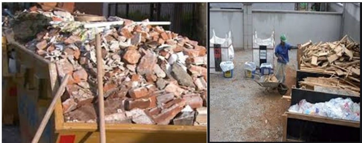
Figura 12 - Vista da caçamba de entulho com materiais de demolição na fase 2
