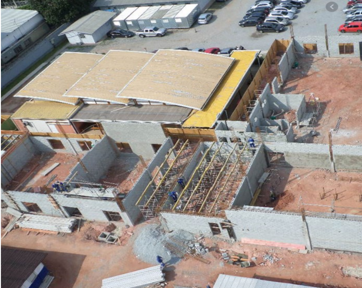
Figura 11 - Vista aérea da área de produção e materiais no terreno na fase 2
