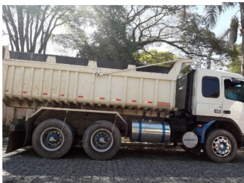
Figura 10 -Retirada de Resíduos sólidos gerados pelo processo de demolição - caminhão com capacidade para 12 metros cúbicos.
