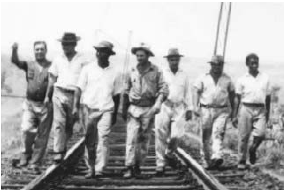
Figura 4: 1961 - Trabalhadores da via permanente. Foto cedida pelo fotógrafo de São Carlos.
