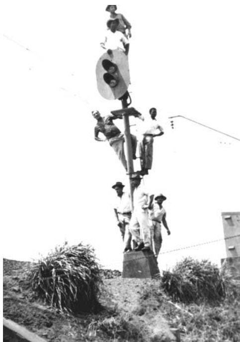
Figura 6: 1961 - trabalhadores da subestação. Foto cedida pelo senhor Adriano (negro).
