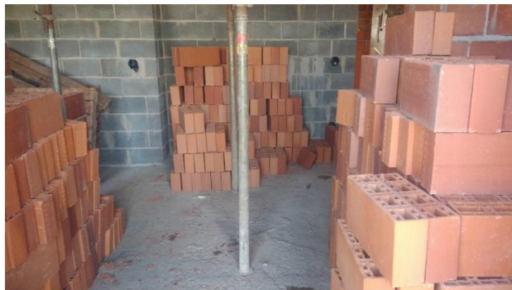
Figura 32 - Estocagem de blocos cerâmicos no pavimento do AV03
