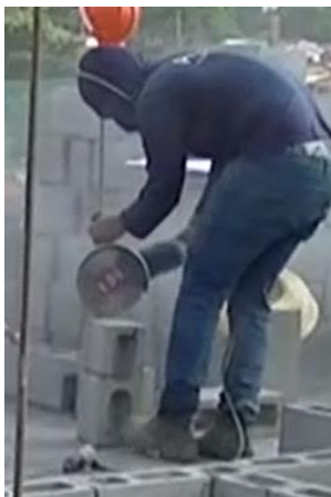
Figura 42 – Corte do bloco de concreto com máquina de corte
