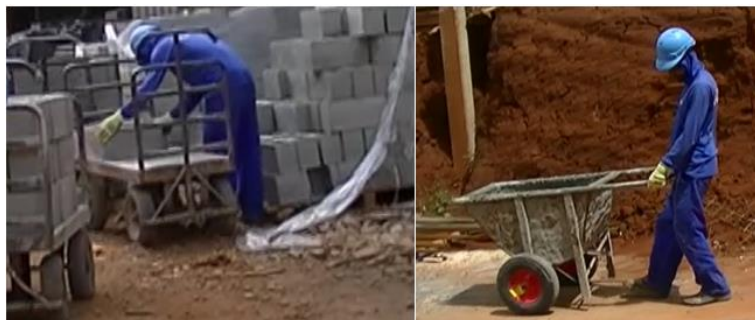
Figura 40 - Transporte de blocos de concreto e de argamassa e graute no local de estocagem
