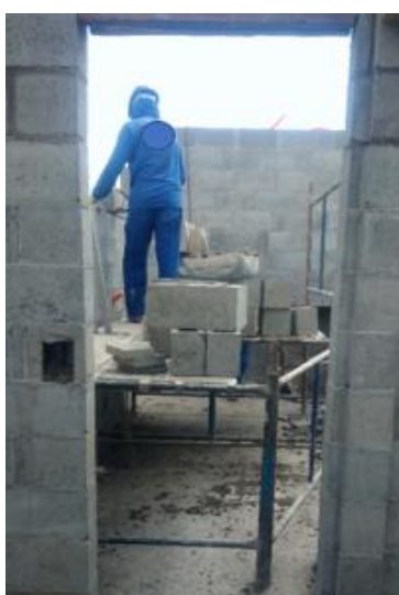
Figura 41 - Organização do posto de trabalho dos pedreiros do AE08
