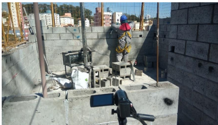
Figura 29 - Distribuição dos materiais no posto de trabalho do AE04
