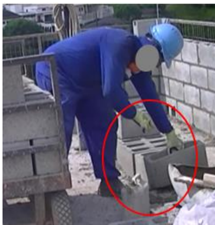
Figura 50 - Trabalhador do AE06 a pegar o bloco de concreto (pega em pinça dos blocos de concreto)
