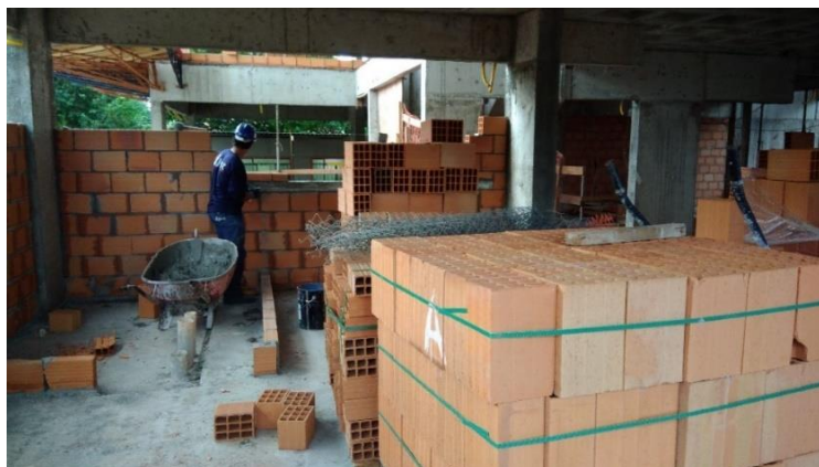
Figura 27 - Distribuição dos materiais no posto de trabalho do AV01
