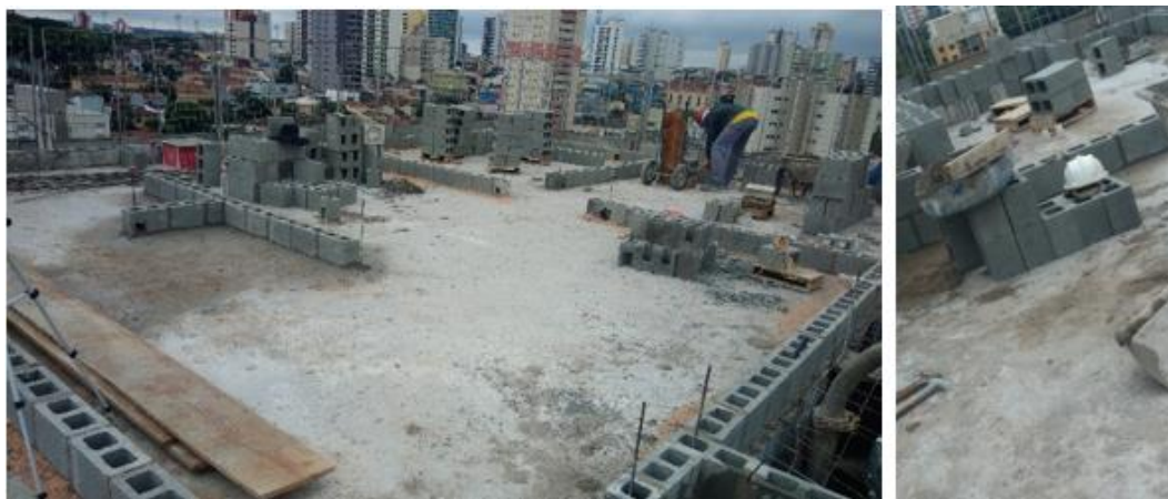
Figura 35 - Organização do posto de trabalho dos pedreiros do AE06
