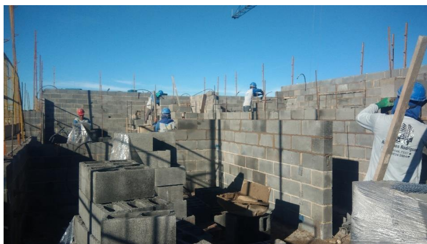
Figura 37 - Posto de trabalho dos pedreiros do AE07
