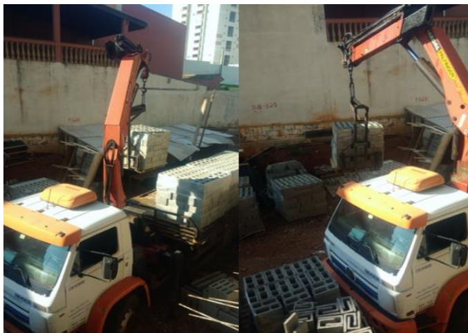
Figura 38 - Utilização do caminhão guindaste para transporte dos paletes de blocos de concreto
