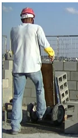
Figura 34 - Transporte de blocos de concreto no pavimento
