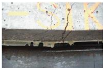
c) Viga P2
