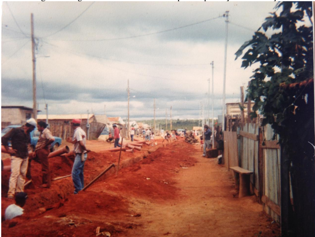
Foto 3 - Registro fotográfico da abertura das ruas para implantação da tubulação
