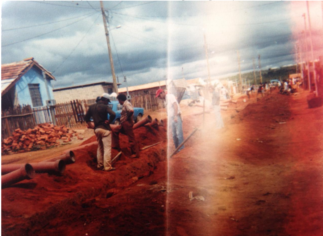
Foto 4 - Registro fotográfico da abertura das ruas para implantação da tubulação
