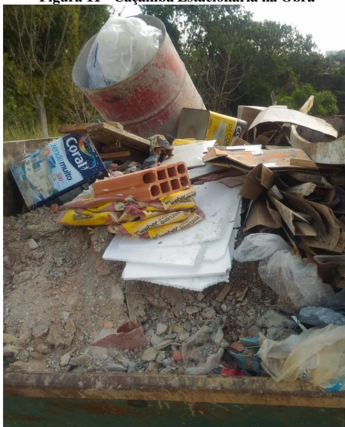
Figura 11 - Caçamba Estacionária na Obra
