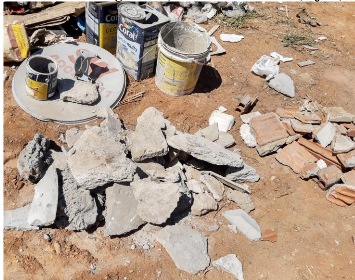
Figura 14 - Resíduo de Concreto e Argamassa, Material Cerâmico (Tijolo) e Material de Pintura
